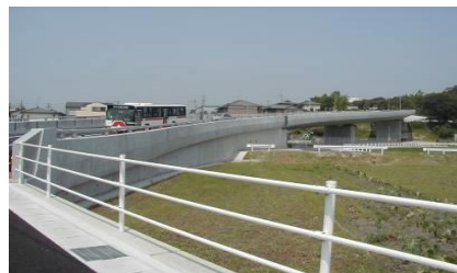
壁高欄 劣化防止
