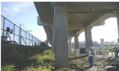
橋脚 中性化防止
