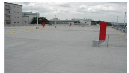
駐車場 スラブ面強化(防塵)
