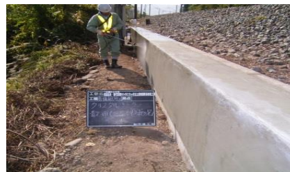
擁壁補修 表面保護
