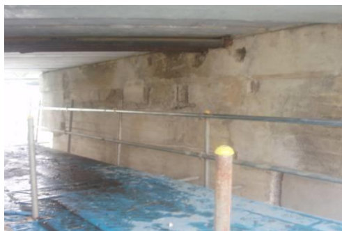
橋梁 劣化防止
