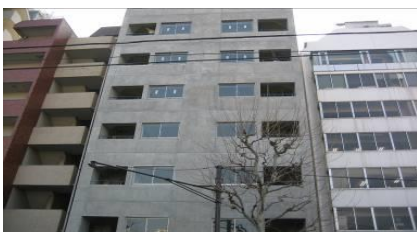
マンション外壁疎水材塗布
