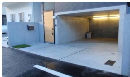
駐車場土間 防塵
