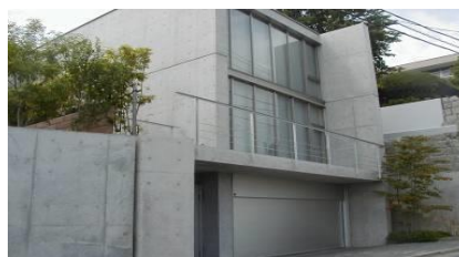
住宅外壁疎水材塗布
