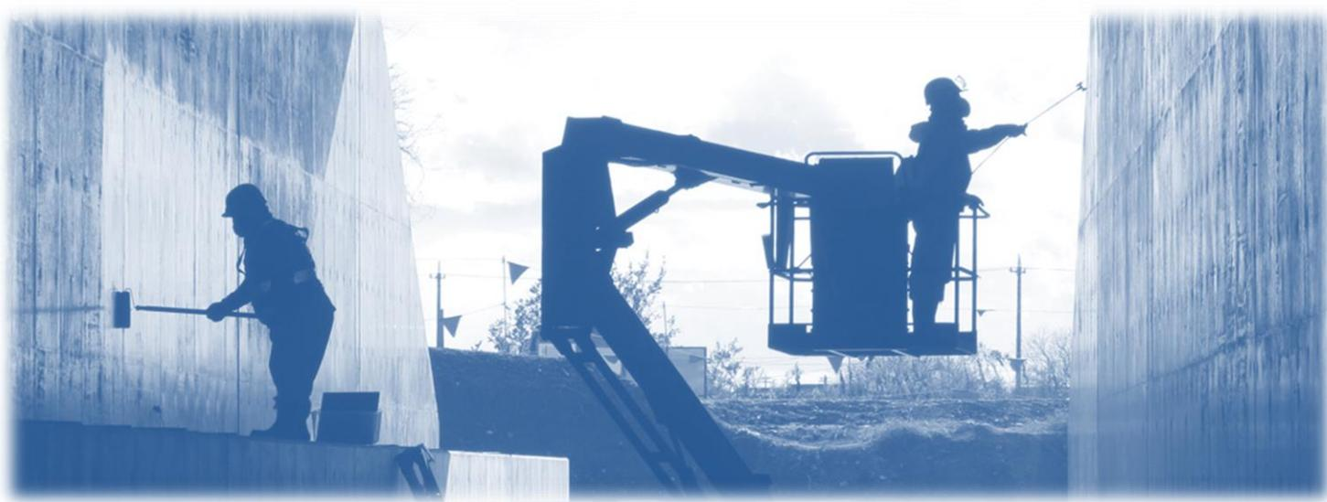
バリアシランはアルコキシシロキサンを主成分とした表面含浸材です。コンクリートやモルタル等の多孔質材料へ塗布、浸透させることにより、強固な吸水防止層を早期に形成し、塩化物イオンや水分等の劣化因子の侵入を抑制します。
