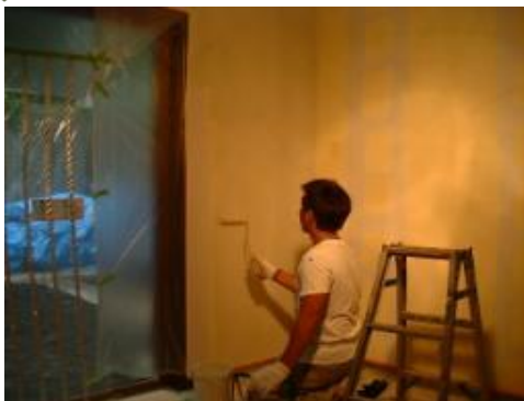
施工中(宿泊施設・神奈川)
