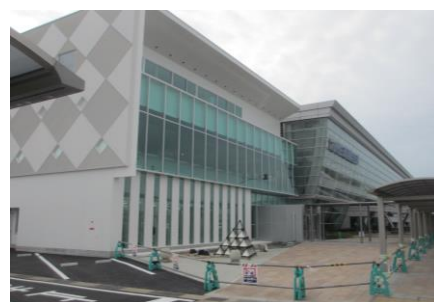
施工後(空港施設外壁・佐賀)
