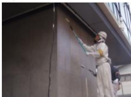
施工中(研究施設外部・東京)
