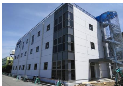
施工後(社屋外壁・長崎)
