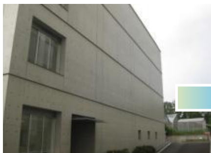
施工後(教育施設外壁・愛知)
