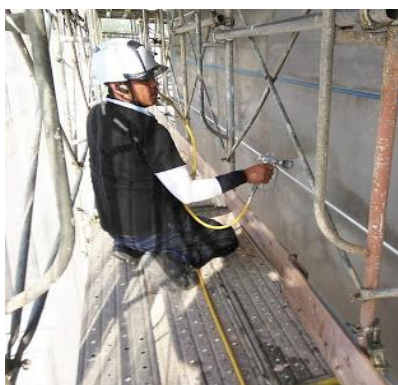
ナノコートプライマー塗布状況
