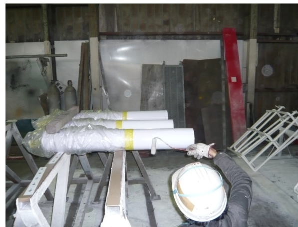
■ 工事名:西公園~百道防護柵補修工事(30-1) ■ 施工年:2019年 ■ 施工場所:福岡県 ■ 施工数量:337㎡ ■ 目的:高速道路防護柵鋼製支柱地際腐食対策
