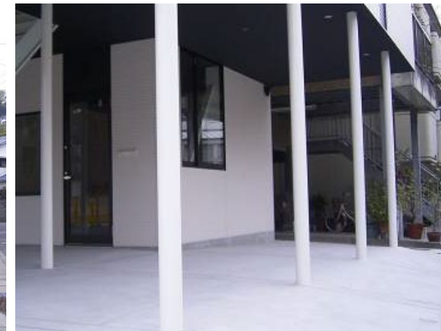
■ 工事名:M's邸新築工事 ■ 施工年:2010年 ■ 施工場所:長崎県 ■ 施工数量:8㎡ ■ 目的:鉄骨丸柱 美装及び美観保持(下塗り:一般錆止め使用)
