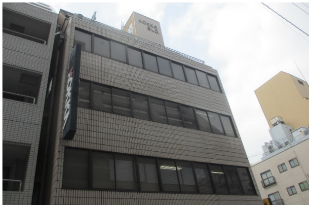
■ 工事名:都内ビル外壁改修工事 ■ 施工年:2020年 ■ 施工場所:東京都 ■ 施工数量:109㎡ ■ 目的:タイルおよびモルタル目地表面保護
