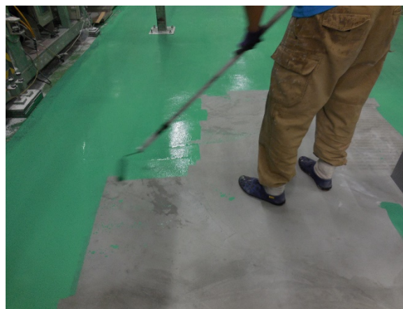
■ 工事名:ユニ・チャームペットケア(株)三重工場床面塗装工事 ■ 施工年:2014年 ■ 施工場所:三重県 ■ 施工数量:400㎡ ■ 目的:コンクリート床塗り替え・防塵・防滑(USCPモルタル併用)
