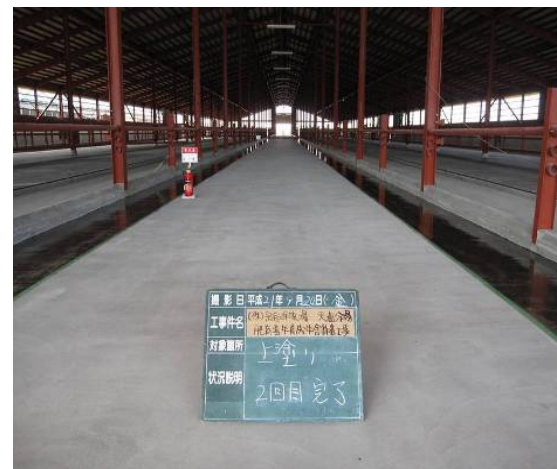
■ 工事名:宗谷岬牧場天塩分場肥育素牛育成牛舎新築工事 ■ 施工年:2009年 ■ 施工場所:北海道 ■ 施工数量:294㎡ ■ 目的:飼槽土間コンクリート(クリスタルストーンNR併用)
