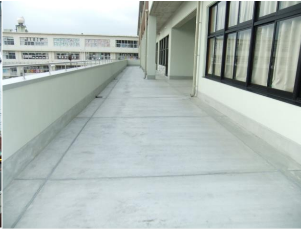
■ 工事名: 福江小学校校舎改築工事 ■ 施工年: 2014年 ■ 施工場所: 長崎県 ■ 施工数量: 1,527㎡ ■ 目的: スカイデッキ及びテラス・表面強化(艶ありタイプを使用)
