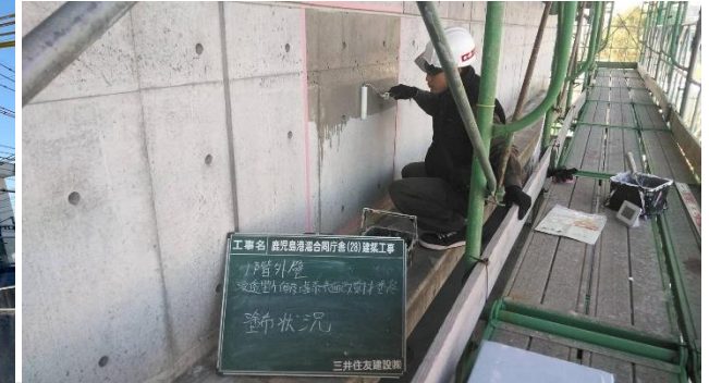
■ 工事名: 鹿児島港湾合同庁舎(28) 建築工事 ■ 施工年: 2020年 ■ 施工場所: 鹿児島県 ■ 施工数量: 233㎡ ■ 目的: 外壁打ち放し面(上塗り: フッ素樹脂塗装)
