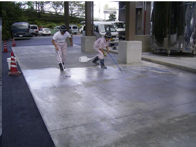
■工事名:中日本冰糖(株)土間コーティング工事 ■施工年:2007年 ■施工場所:岐阜県 ■施工数量:97㎡ ■目的:搬出入口コンクリート土間防塵・防汚(艶ありタイプを使用)
