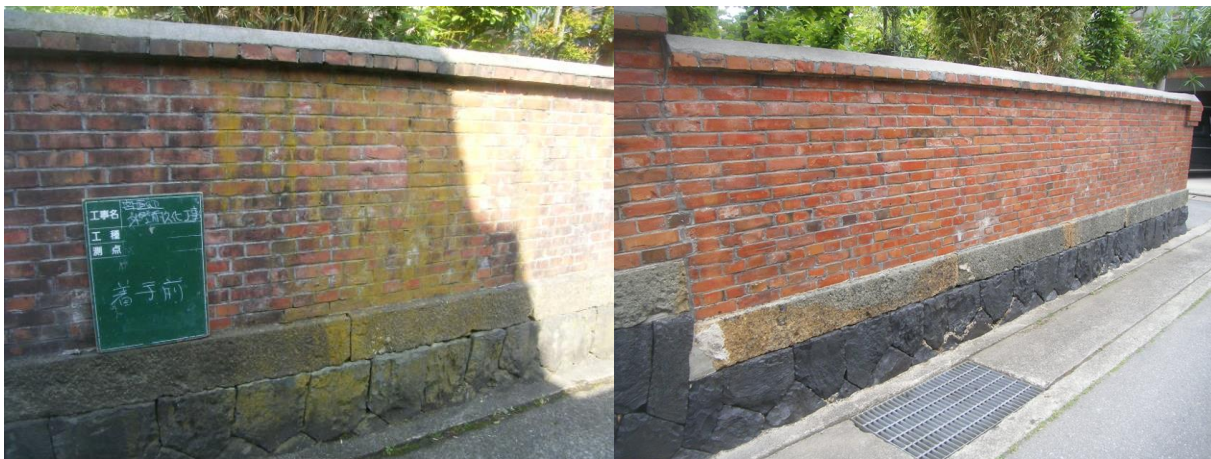
■工事名:個人住宅外壁等耐久化工事 ■施工年:2013年 ■施工場所:兵庫県 ■施工数量:不明 ■目的:レンガ塀(築100年)表層緻密化
