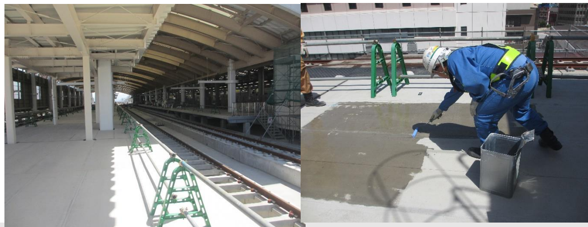
■工事名:信越新潟駅高架化駅西 ■施工年:2017年 ■施工場所:新潟県 ■施工数量:600㎡ ■目的:
