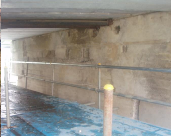
■工事名:平成17年度橋梁補修工事(県単)その1 ■施工年:2006年 ■施工場所:神奈川県 ■施工数量:100㎡ ■目的:中性化対策
