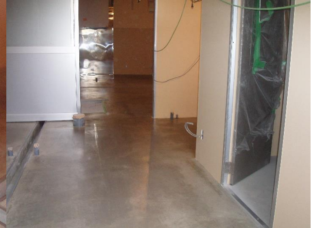
■工事名:ラ・テール店舗新築工事 ■施工年:2008年 ■施工場所:東京都 ■施工数量:90㎡ ■目的:厨房床コンクリート防塵 防汚(艶ありタイプを使用)
