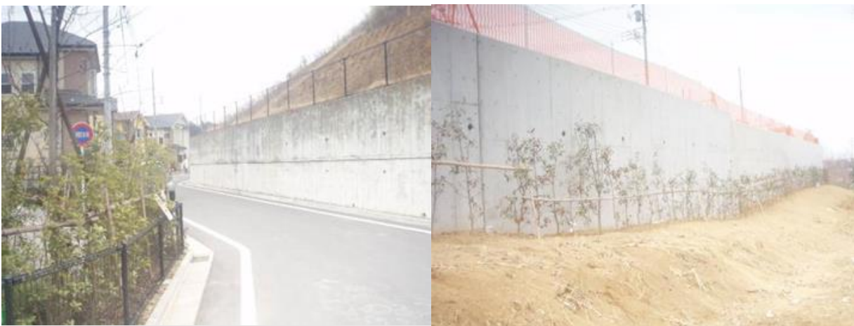
■工事名:八王子住宅擁壁強化材塗布工事 ■施工年:2007年 ■施工場所:東京都 ■施工数量:1,000㎡ ■目的:擁壁コンクリート中性化対策
