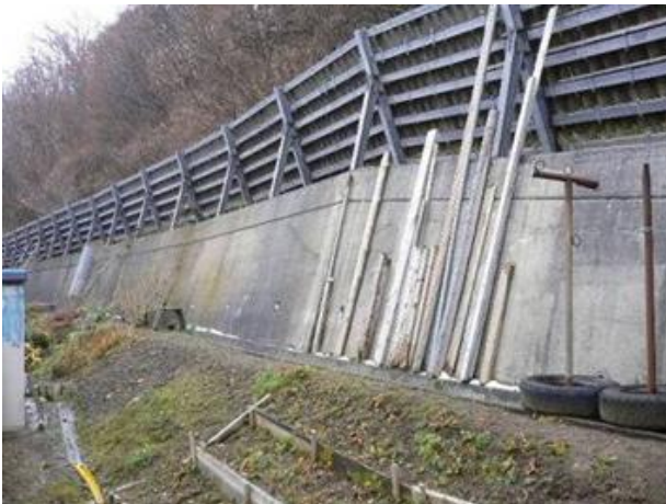
■ 工事名:島牧村原歌地区擁壁補修工事 ■ 施工年:2007年 ■ 施工場所:北海道 ■ 施工数量:不明 ■ 目的:コンクリート擁壁劣化対策(USCPモルタル併用)
