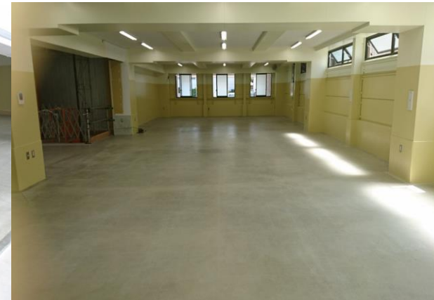
■ 工事名: インテックス増改築工事 ■ 施工年: 2016年 ■ 施工場所: 長崎県 ■ 施工数量: 1,000㎡ ■ 目的: コンクリート作業場床防塵(艶ありタイプを使用)
