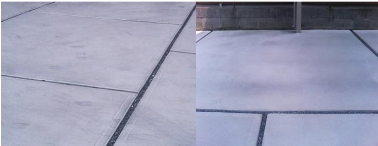
■工事名:S邸駐車場強化剤塗布工事 ■施工年:2007年 ■施工場所:愛知県 ■施工数量:20㎡ ■目的:土間コンクリート防塵対策
