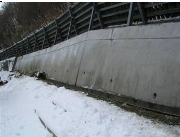
■ 工事名:島牧村原歌地区擁壁補修工事 ■ 施工年:2007年 ■ 施工場所:北海道 ■ 施工数量:不明 ■ 目的:コンクリート擁壁劣化対策(USCPモルタル併用)
