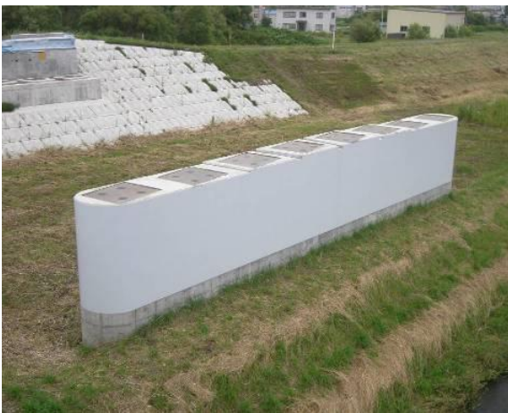
■工事名:山本栄橋 地覆防食工 落書防止工事 ■施工年:2009年 ■施工場所:北海道 ■施工数量:400㎡ ■目的:コンクリート部 防食
