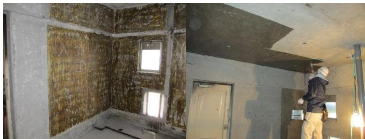
■ 工事名: 県営住宅(河原木団地)11号棟火災復旧工事 ■ 施工年: 2012年 ■ 施工場所: 青森県 ■ 施工数量: 232㎡ ■ 目的: 既設PC及びRC内装(天井・壁等)表層緻密化、アルカリ性付与
