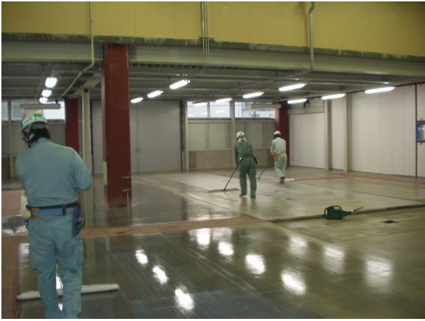
■ 工事名:自動車部品工場新築工事(岡崎) ■ 施工年:2005年 ■ 施工場所:愛知県 ■ 施工数量:45,454㎡ ■ 目的:コンクリート床表面強化・耐油性(艶ありタイプを使用)
