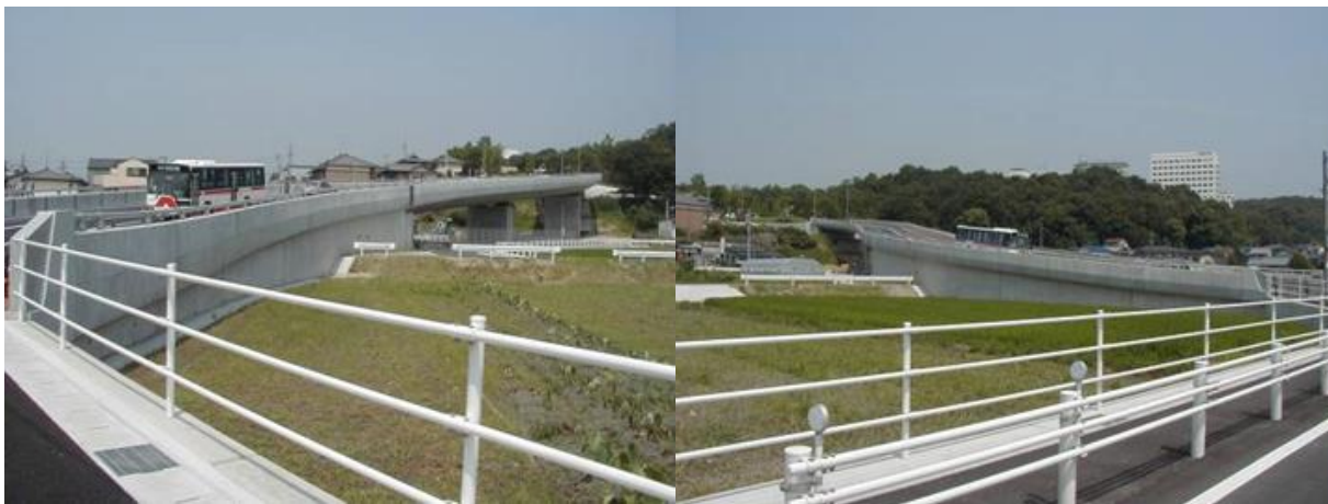
■ 工事名: 中部大学橋梁新設工事 ■ 施工年: 2005年 ■ 施工場所: 愛知県 ■ 施工数量: 1,000㎡ ■ 目的: 壁高欄劣化対策
