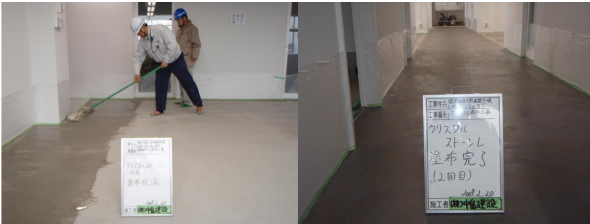
■ 工事名: 横浜国大建築学棟8Fラウンジ及び廊下液体ガラス塗布工事 ■ 施工年: 2009年 ■ 施工場所: 神奈川県 ■ 施工数量: 200㎡ ■ 目的: コンクリート床表面保護(艶ありタイプを使用)
