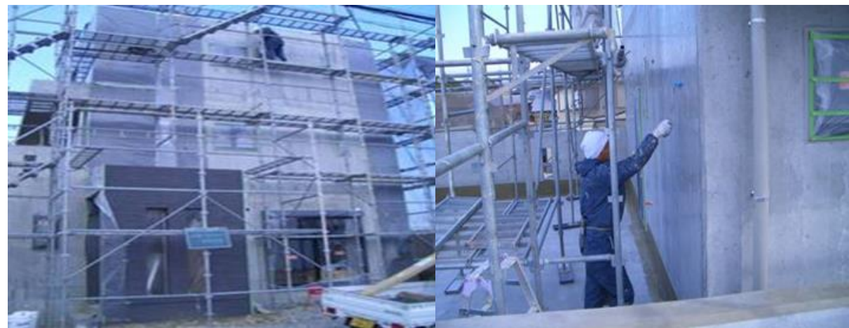
■工事名:徳島個人様住宅新築工事 ■施工年:2007年 ■施工場所:徳島県 ■施工数量:250㎡ ■目的:コンクリート外壁等劣化対策
