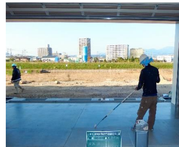
■ 工事名: 新唐津給食センター建設建築工事(床) ■ 施工年: 2016年 ■ 施工場所: 佐賀県 ■ 施工数量: 230㎡ ■ 目的: コンクリート床表面強化(艶ありタイプを使用)
