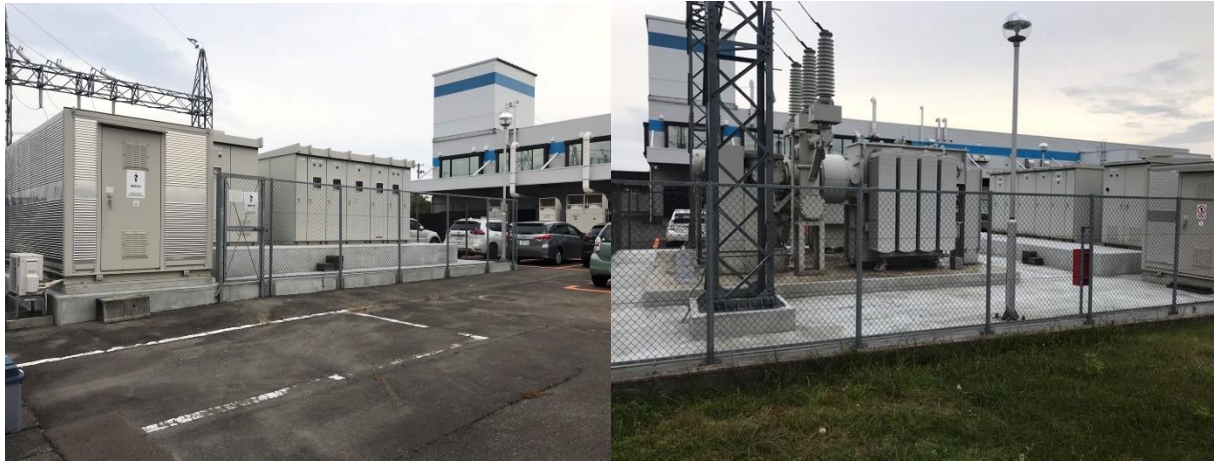
■ 工事名: イーエヌ大塚製薬受変電設備基礎コンクリート改修工事 ■ 施工年: 2020年 ■ 施工場所: 岩手県 ■ 施工数量: 500㎡ ■ 目的: 受変電設備基礎コンクリート緻密化、耐久性向上
