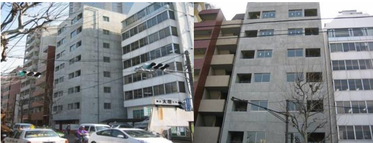
■工事名:西新宿RC造ビル8F外壁工事 ■施工年:2007年 ■施工場所:東京都 ■施工数量:1,500㎡ ■目的:コンクリート外壁劣化対策
