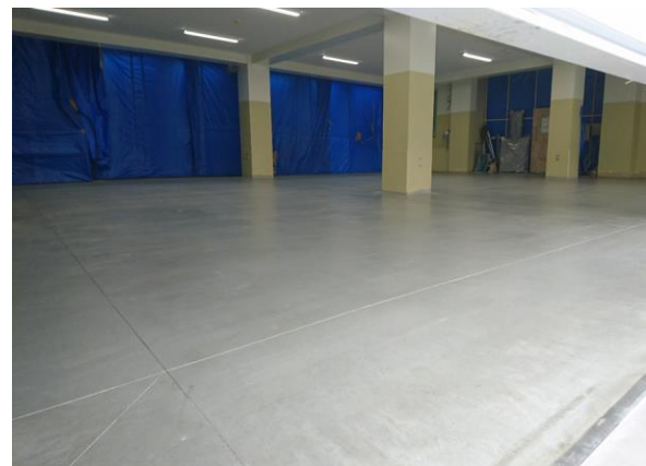
■ 工事名: インテックス増改築工事 ■ 施工年: 2016年 ■ 施工場所: 長崎県 ■ 施工数量: 1,000㎡ ■ 目的: コンクリート作業場床防塵(艶ありタイプを使用)
