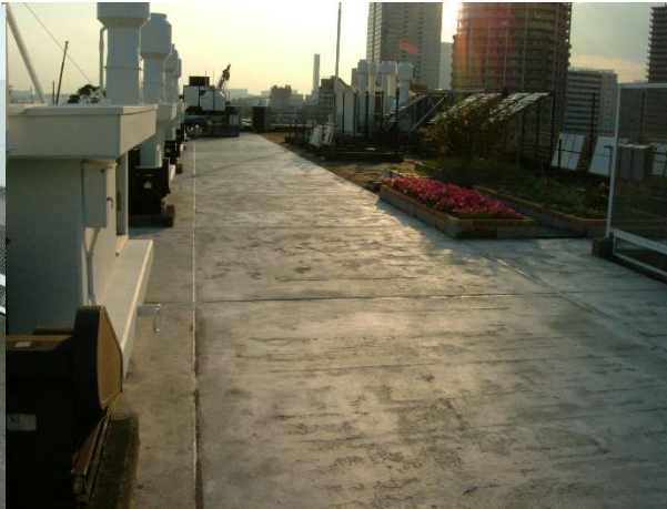
■ 工事名:清水建設(株)技研中央棟屋上強化剤塗布工事 ■ 施工年:2003年 ■ 施工場所:東京都 ■ 施工数量:100㎡ ■ 目的:屋上シンダーコンクリートスラブ劣化対策(艶有タイプを使用)
