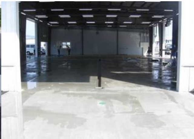
■ 工事名:FWT茨城車両検査工場新築工事 ■ 施工年:2009年 ■ 施工場所:茨城県 ■ 施工数量:521㎡ ■ 目的:工場土間・内壁コンクリート長期耐久、劣化防止、耐薬品性の向上
