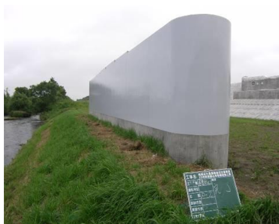
■工事名:山本栄橋 地覆防食工 落書防止工事 ■施工年:2009年 ■施工場所:北海道 ■施工数量:400㎡ ■目的:コンクリート部 防食
