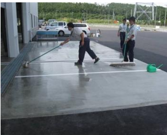
■ 工事名:FWT茨城車両検査工場新築工事 ■ 施工年:2009年 ■ 施工場所:茨城県 ■ 施工数量:521㎡ ■ 目的:工場土間・内壁コンクリート長期耐久、劣化防止、耐薬品性の向上
