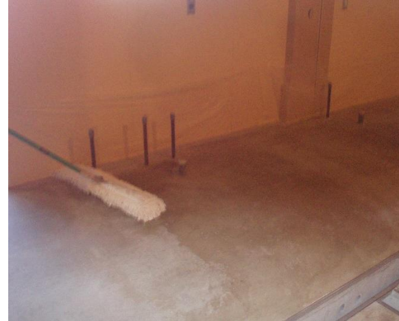
■工事名:ラ・テール店舗新築工事 ■施工年:2008年 ■施工場所:東京都 ■施工数量:90㎡ ■目的:厨房床コンクリート防塵 防汚(艶ありタイプを使用)
