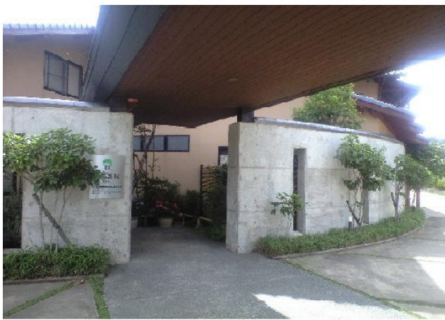
■ 工事名: 病院コンクリート外壁クリスタルストーン施工 ■ 施工年: 2013年 ■ 施工場所: 兵庫県 ■ 施工数量: 100㎡ ■ 目的: コンクリート表面保護
