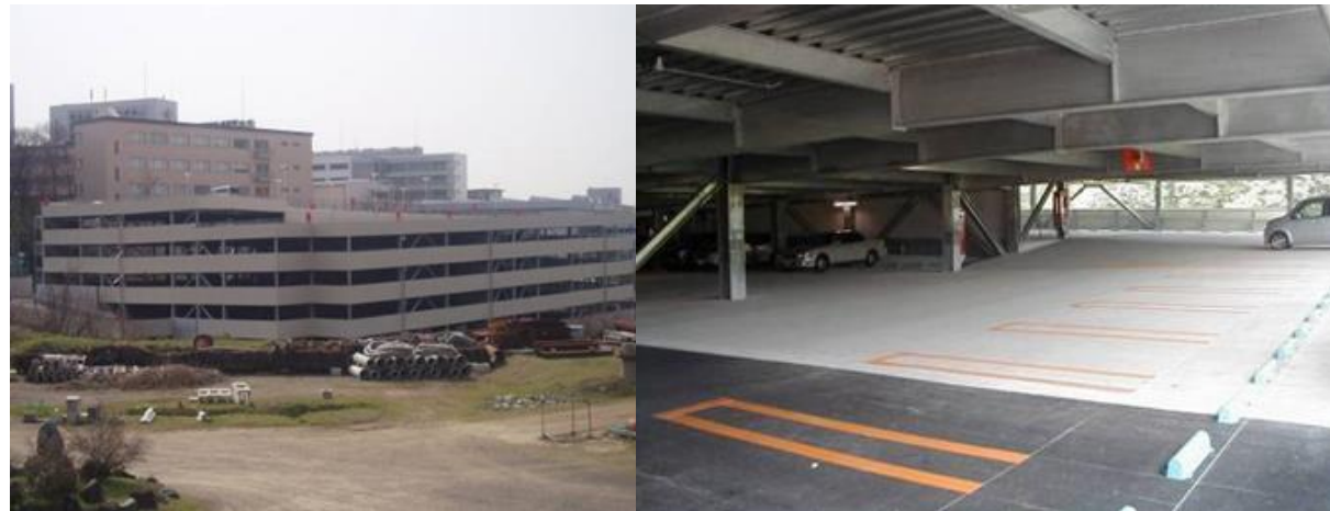
■ 工事名: 中部大学立体駐車場新設工事 ■ 施工年: 2005年 ■ 施工場所: 愛知県 ■ 施工数量: 2,860㎡ ■ 目的: コンクリートスラブ面劣化対策
