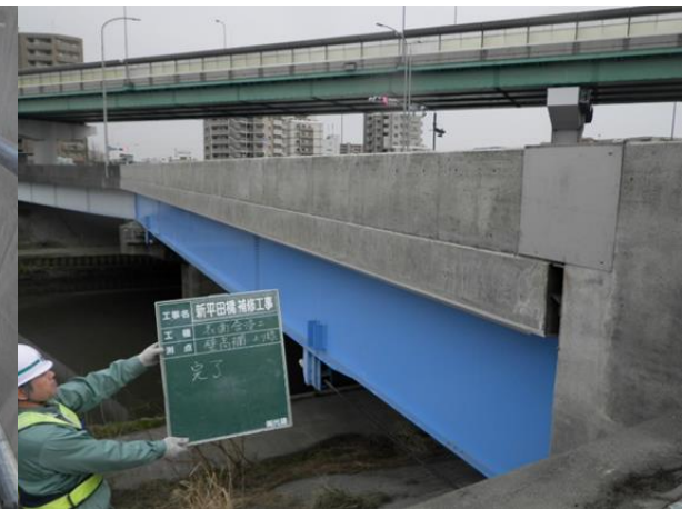
■ 工事名: 新平田橋補修工事 ■ 施工年: 2017年 ■ 施工場所: 愛知県 ■ 施工数量: 1,282㎡ ■ 目的: 橋梁表面保護工 中性化抑制
