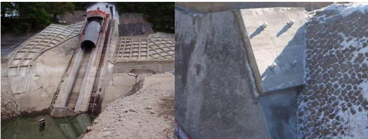
■ 工事名:羽鳥ダム取水樋門下部工補強工事 ■ 施工年:2009年 ■ 施工場所:福島県 ■ 施工数量:214㎡ ■ 目的:ダム劣化対策
