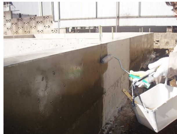
■工事名:世田谷区K様邸新築工事 ■施工年:2008年 ■施工場所:東京都 ■施工数量:30㎡ ■目的:コンクリート基礎劣化対策
