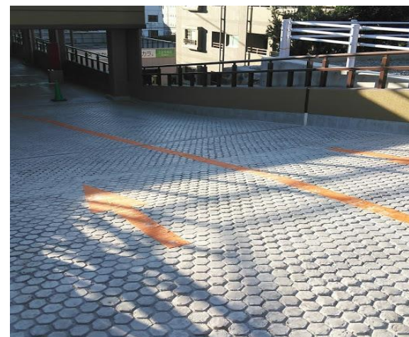
■ 工事名: 諏訪神社付属駐車場新築工事 ■ 施工年: 2017年 ■ 施工場所: 長崎県 ■ 施工数量: 600㎡ ■ 目的: コンクリートスロープ床表面保護(艶ありタイプを使用)
