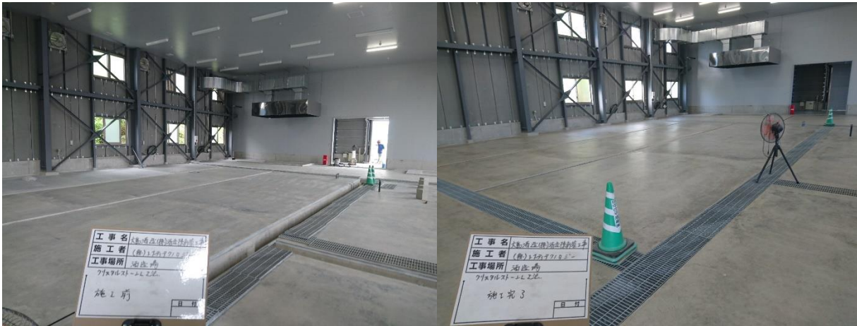
■工事名:大島酒造(株)酒造棟新築工事 ■施工年:2017年 ■施工場所:長崎県 ■施工数量:440㎡ ■目的:作業場コンクリート床防塵・防汚・衛生(艶ありタイプを使用)
