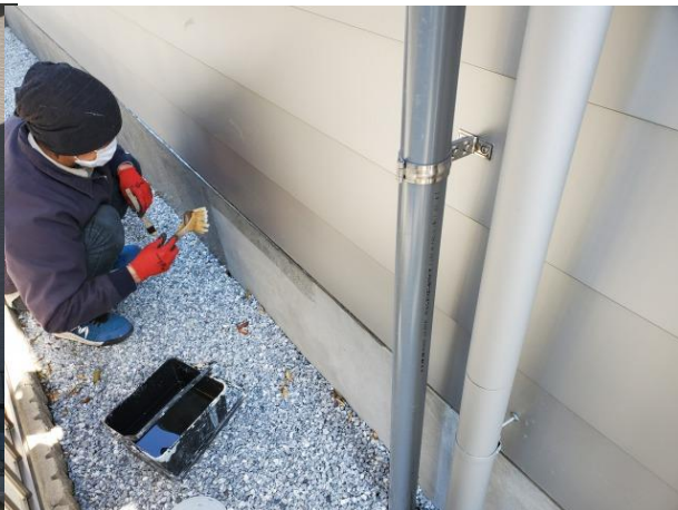
■ 工事名: 個人住宅新築工事 ■ 施工年: 2020年 ■ 施工場所: 静岡県 ■ 施工数量: 193㎡ ■ 目的: 駐車場、擁壁等表面保護、劣化対策
