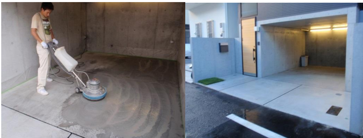
■ 工事名: Y様邸新築工事 ■ 施工年: 2010年 ■ 施工場所: 東京都 ■ 施工数量: 214㎡ ■ 目的: 駐車場土間コンクリート防塵対策
