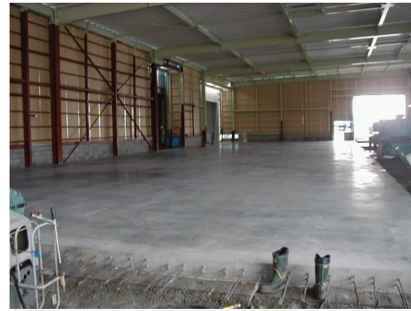
■ 工事名:自動車部品工場増設工事(蒲郡) ■ 施工年:2005年 ■ 施工場所:愛知県 ■ 施工数量:1,528㎡ ■ 目的:コンクリート床表面強化・耐油性(艶ありタイプを使用)
