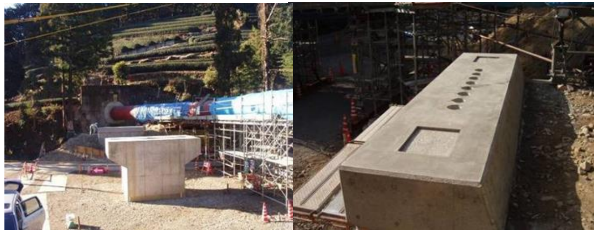
■工事名:島田市水路 基礎劣化防止工事 ■施工年:2005年 ■施工場所:静岡県 ■施工数量:33㎡ ■目的:水路基礎劣化対策
