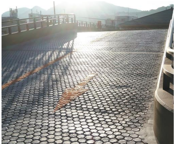
■ 工事名: 諏訪神社付属駐車場新築工事 ■ 施工年: 2017年 ■ 施工場所: 長崎県 ■ 施工数量: 600㎡ ■ 目的: コンクリートスロープ床表面保護(艶ありタイプを使用)
