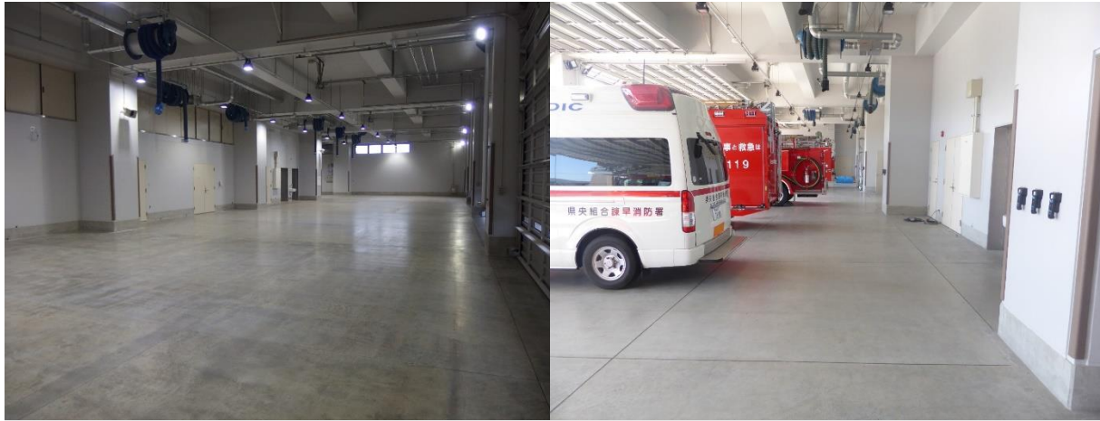
■ 工事名: 諫早消防署新庁舎新築(建築主体)工事 ■ 施工年: 2013年 ■ 施工場所: 長崎県 ■ 施工数量: 1,182㎡ ■ 目的: 庁舎棟床、駐車場棟ほかコンクリート床防塵(艶ありタイプを使用)
