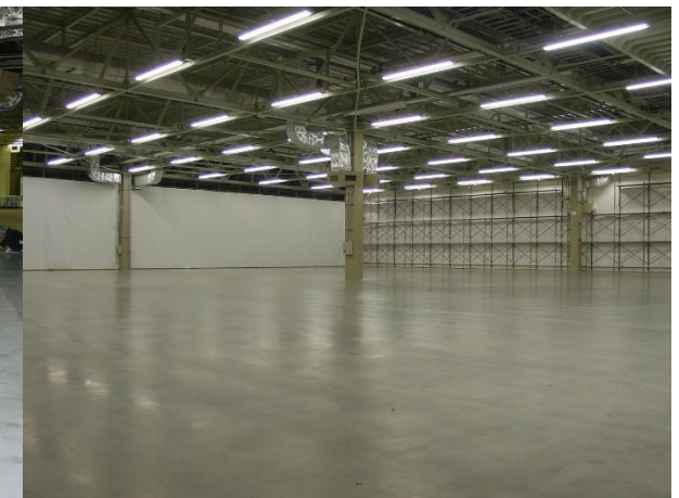
■ 工事名:自動車部品工場新築工事(田原) ■ 施工年:2002年 ■ 施工場所:愛知県 ■ 施工数量:36,770㎡ ■ 目的:コンクリート床表面強化・耐油性(艶ありタイプを使用)
