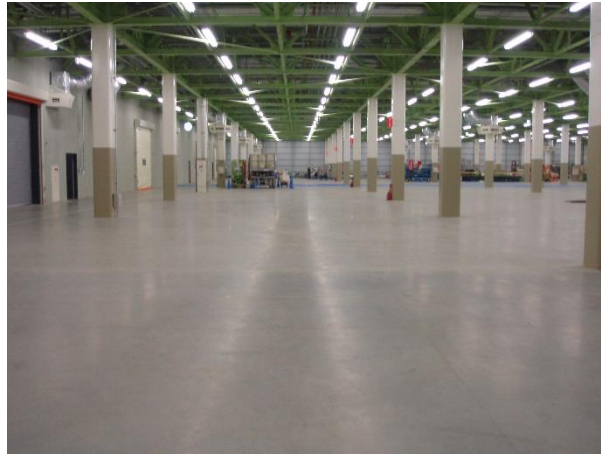
■ 工事名:自動車部品工場新築工事(岡崎) ■ 施工年:2005年 ■ 施工場所:愛知県 ■ 施工数量:45,454㎡ ■ 目的:コンクリート床表面強化・耐油性(艶ありタイプを使用)
