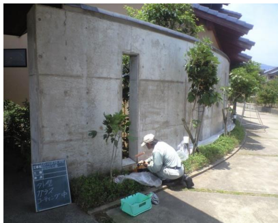
■ 工事名: 病院コンクリート外壁クリスタルストーン施工 ■ 施工年: 2013年 ■ 施工場所: 兵庫県 ■ 施工数量: 100㎡ ■ 目的: コンクリート表面保護
