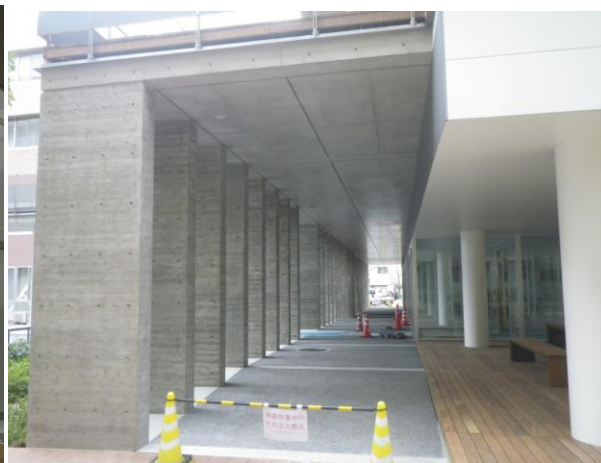
■ 工事名: 就実大学新B館新築工事 ■ 施工年: 2016年 ■ 施工場所: 岡山県 ■ 施工数量: 866㎡ ■ 目的: コンクリート床防塵(艶ありタイプを使用)
