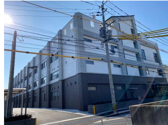
■ 工事名: 鹿児島港湾合同庁舎(28) 建築工事 ■ 施工年: 2020年 ■ 施工場所: 鹿児島県 ■ 施工数量: 233㎡ ■ 目的: 外壁打ち放し面(上塗り: フッ素樹脂塗装)
