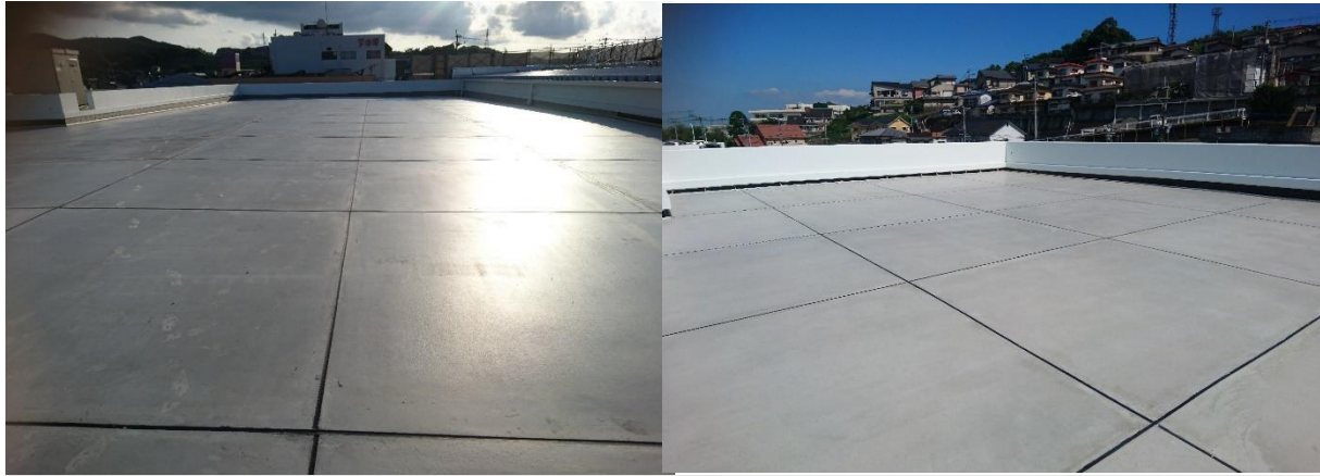
■工事名:長崎トヨペット諫早店改築工事 ■施工年:2017年 ■施工場所:長崎県 ■施工数量:1,455㎡ ■目的:駐車場・洗車場コンクリート床防塵・防汚(艶ありタイプを使用)
