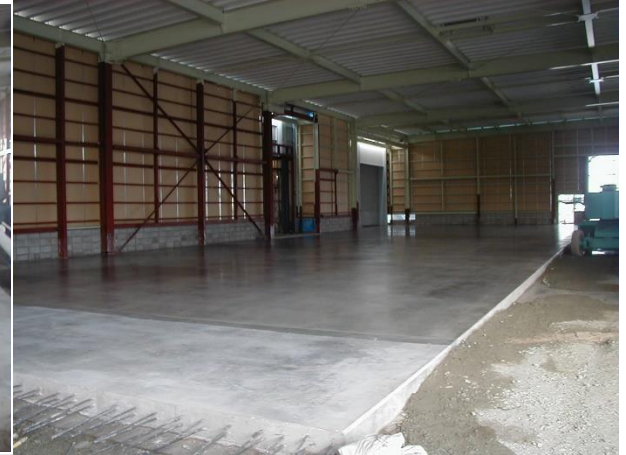
■ 工事名:自動車部品工場増設工事(蒲郡) ■ 施工年:2005年 ■ 施工場所:愛知県 ■ 施工数量:1,528㎡ ■ 目的:コンクリート床表面強化・耐油性(艶ありタイプを使用)
