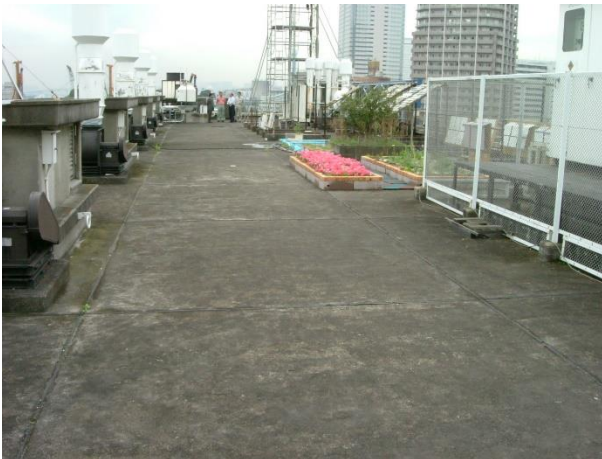
■ 工事名:清水建設(株)技研中央棟屋上強化剤塗布工事 ■ 施工年:2003年 ■ 施工場所:東京都 ■ 施工数量:100㎡ ■ 目的:屋上シンダーコンクリートスラブ劣化対策(艶有タイプを使用)
