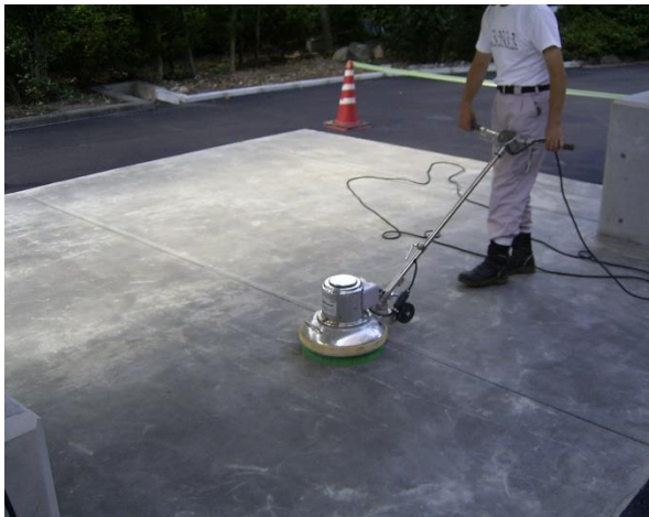
■工事名:中日本冰糖(株)土間コーティング工事 ■施工年:2007年 ■施工場所:岐阜県 ■施工数量:97㎡ ■目的:搬出入口コンクリート土間防塵・防汚(艶ありタイプを使用)
