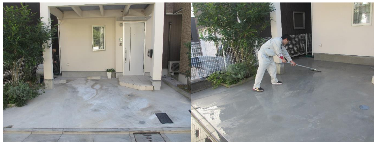
■ 工事名: 個人住宅新築工事 ■ 施工年: 2015年 ■ 施工場所: 東京都 ■ 施工数量: 18㎡ ■ 目的: 駐車場等コンクリート表面防汚
