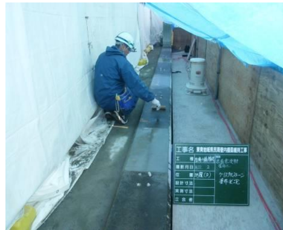
■工事名:西滝川補修工事 ■施工年:2010年 ■施工場所:青森県 ■施工数量:300㎡ ■目的:コンクリート桁・地覆 防食
