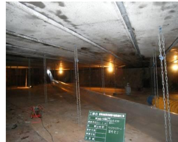
■工事名:西滝川補修工事 ■施工年:2010年 ■施工場所:青森県 ■施工数量:300㎡ ■目的:コンクリート桁・地覆 防食
