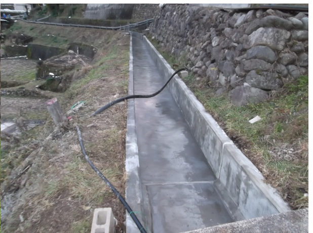
■ 工事名:大和南地区島用水路第3号工事 ■ 施工年:2013年 ■ 施工場所:岐阜県 ■ 施工数量:400m 2 (t=6mm) ■ 目的:水路内面補修、耐摩耗性、凍害対策
