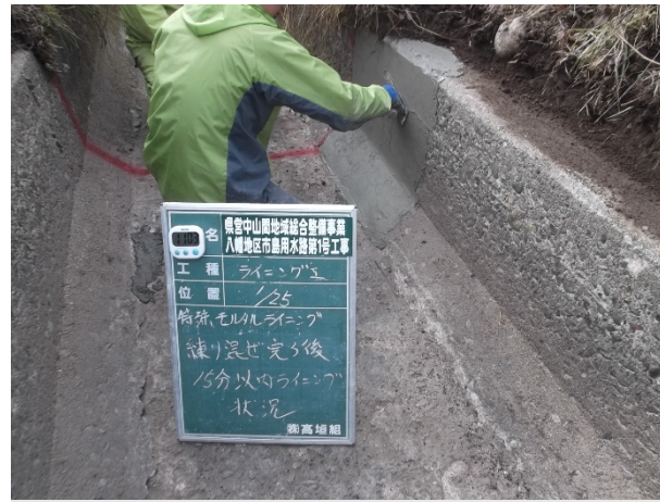
■ 工事名:八幡地区市島用水路第1号工事 ■ 施工年:2014年 ■ 施工場所:岐阜県 ■ 施工数量:700m 2 (t=6mm) ■ 目的:水路内面補修、耐摩耗性、凍害対策
