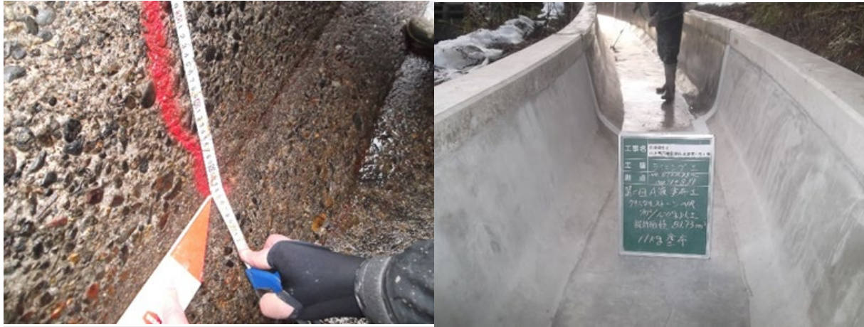
■ 工事名:郡上西部地区剣用水路第4号工事 ■ 施工年:2012年 ■ 施工場所:岐阜県 ■ 施工数量:500㎡(t=6mm) ■ 目的:水路内面補修、耐摩耗性、凍害対策
