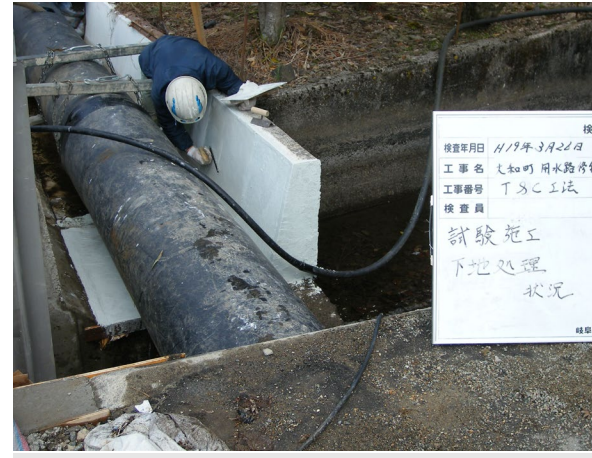
■ 工事名: 大和町用水路改良工事 ■ 施工年: 2007年 ■ 施工場所: 岐阜県 ■ 施工数量: 3㎡ (t=6mm) ■ 目的: 補修・長寿命化
