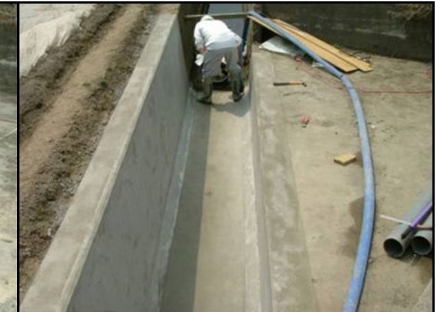
■ 工事名: 山王下第2地区水路補修工事 ■ 施工年: 2006年 ■ 施工場所: 群馬県 ■ 施工数量: 96㎡ (t=5mm) ■ 目的: 劣化防止
