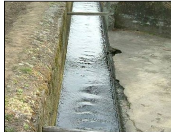
■ 工事名: 山王下第2地区水路補修工事 ■ 施工年: 2006年 ■ 施工場所: 群馬県 ■ 施工数量: 96㎡ (t=5mm) ■ 目的: 劣化防止
