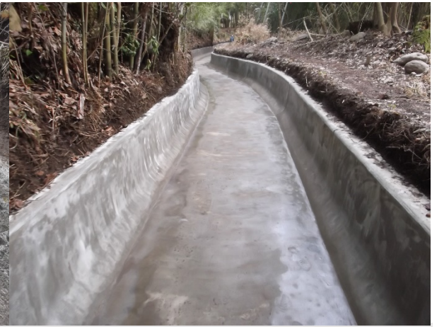
■ 工事名:八幡地区市島用水路第1号工事 ■ 施工年:2014年 ■ 施工場所:岐阜県 ■ 施工数量:700m 2 (t=6mm) ■ 目的:水路内面補修、耐摩耗性、凍害対策
