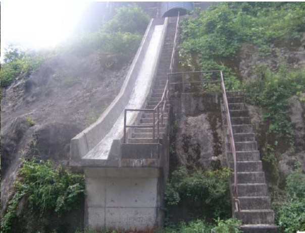
■ 工事名:北陸電力(株)桑島発電所 水槽塵芥ホッパーシュート修繕工事 ■ 施工年:2016年 ■ 施工場所:石川県 ■ 施工数量:31m 2 (t=6mm) ■ 目的:水路内面補修
