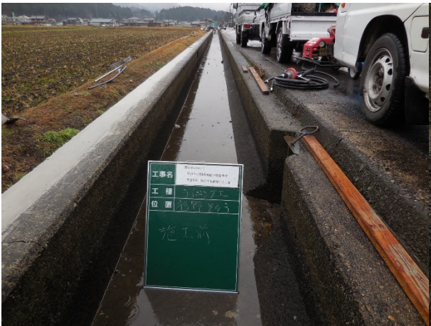
■ 工事名:美並地区美並用水路第1号工事 ■ 施工年:2014年 ■ 施工場所:岐阜県 ■ 施工数量:500m 2 (t=6mm) ■ 目的:水路内面補修、耐摩耗性、凍害対策
