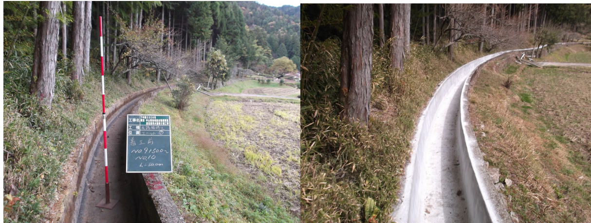
■ 工事名:下呂南部地区東沓部用水路第2期工事 ■ 施工年:2012年 ■ 施工場所:岐阜県 ■ 施工数量:1,000㎡(t=6mm) ■ 目的:水路内面補修、耐摩耗性、凍害対策
