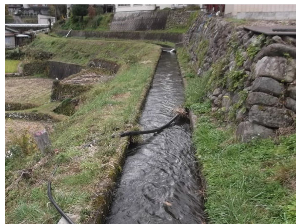
■ 工事名:大和南地区島用水路第3号工事 ■ 施工年:2013年 ■ 施工場所:岐阜県 ■ 施工数量:400m 2 (t=6mm) ■ 目的:水路内面補修、耐摩耗性、凍害対策
