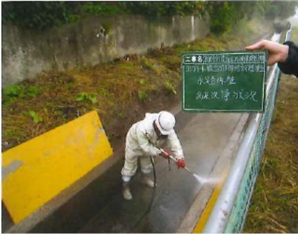
■ 工事名: (試験施工) H2O 農業用水利施設機能診断及び維持補修研修会 ■ 施工年: 2008年 ■ 施工場所: 福島県 ■ 施工数量: 5㎡ (t=5mm) ■ 目的: 福島県土地改良事業団体連合会主催の長寿命化工法検討
