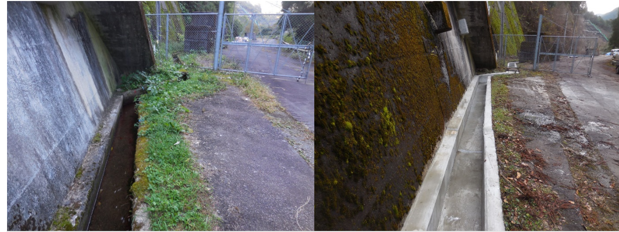
■ 工事名:八幡地区東乙原用水路第2号工事 ■ 施工年:2015年 ■ 施工場所:岐阜県 ■ 施工数量:200㎡(6mm) ■ 目的:水路内面補修、耐摩耗性、凍害対策
