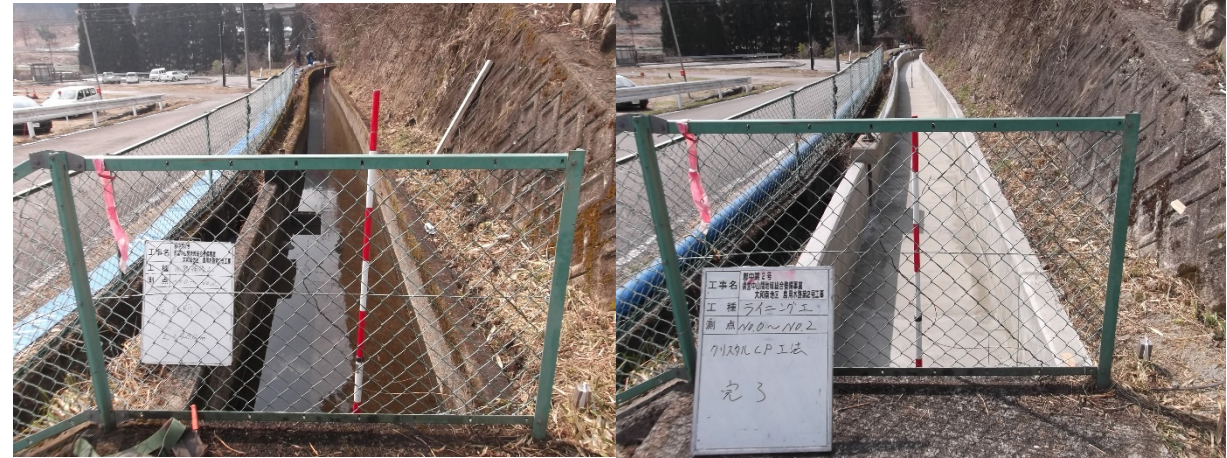
■ 工事名:下呂北部地区萩原小坂連合用水路第2期工事 ■ 施工年:2014年 ■ 施工場所:岐阜県 ■ 施工数量:1,040㎡(t=6mm) ■ 目的:水路内面補修、耐摩耗性、凍害対策
