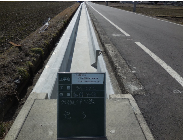
■ 工事名:美並地区美並用水路第1号工事 ■ 施工年:2014年 ■ 施工場所:岐阜県 ■ 施工数量:500m 2 (t=6mm) ■ 目的:水路内面補修、耐摩耗性、凍害対策
