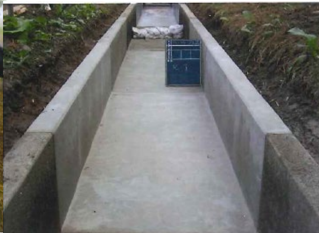
■ 工事名: (試験施工) H2O 農業用水利施設機能診断及び維持補修研修会 ■ 施工年: 2008年 ■ 施工場所: 福島県 ■ 施工数量: 5㎡ (t=5mm) ■ 目的: 福島県土地改良事業団体連合会主催の長寿命化工法検討
