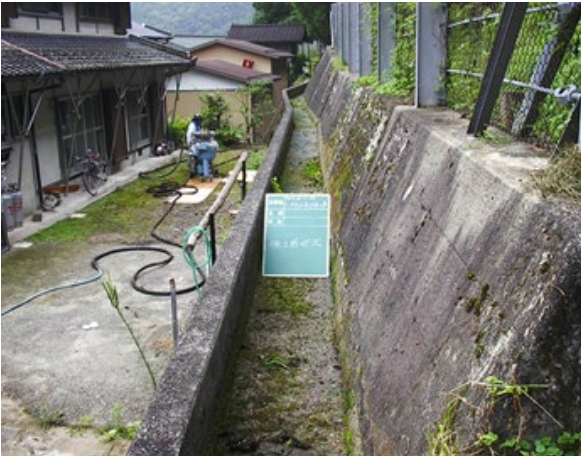
■ 工事名: 大井用水路改良 ■ 施工年: 2007年 ■ 施工場所: 岐阜県 ■ 施工数量: 58㎡ (t=6mm) ■ 目的: 補修・長寿命化
