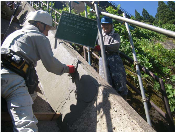
■ 工事名:北陸電力(株)桑島発電所 水槽塵芥ホッパーシュート修繕工事 ■ 施工年:2016年 ■ 施工場所:石川県 ■ 施工数量:31m 2 (t=6mm) ■ 目的:水路内面補修
