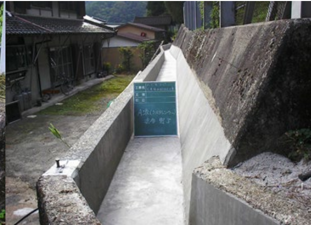
■ 工事名: 大井用水路改良 ■ 施工年: 2007年 ■ 施工場所: 岐阜県 ■ 施工数量: 58㎡ (t=6mm) ■ 目的: 補修・長寿命化
