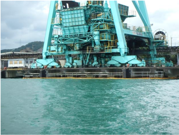
■ 工事名:新日本電工(株)徳島工場(3万トン棧橋補修工事) ■ 施工年:2016年 ■ 施工場所:徳島県 ■ 施工数量:2000㎡ ■ 目的:既設塗膜除去後含浸材塗布・塩害対策
