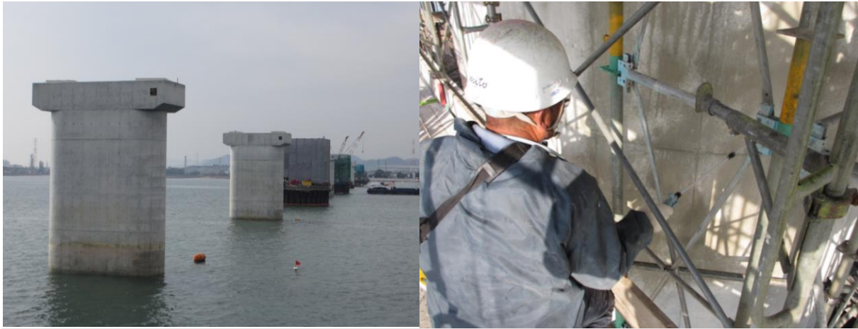
■ 工事名:水島港水島玉島地区臨港道路(渡河部)橋梁下部工事(その3) ■ 施工年:2014年 ■ 施工場所:岡山県 ■ 施工数量:1000㎡ ■ 目的:コンクリート橋脚塩害対策
