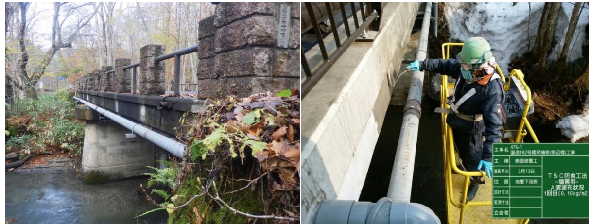
■ 工事名:国道102号橋梁補修(惣辺橋)工事 ■ 施工年:2018年 ■ 施工場所:青森県 ■ 施工数量:260㎡ ■ 目的:骨材露出部PCM補修後含浸材処理
