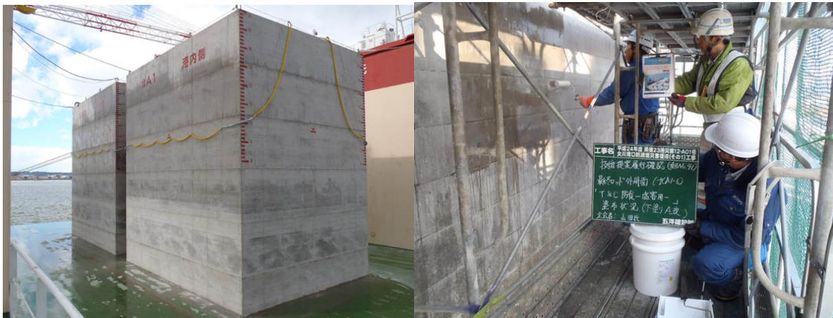
■ 工事名:女川港口防波堤災害復旧(その1)工事 ■ 施工年:2013年 ■ 施工場所:宮城県 ■ 施工数量:650㎡ ■ 目的:遊水部及びスリットを含むケーソン外周部含浸材塗布
