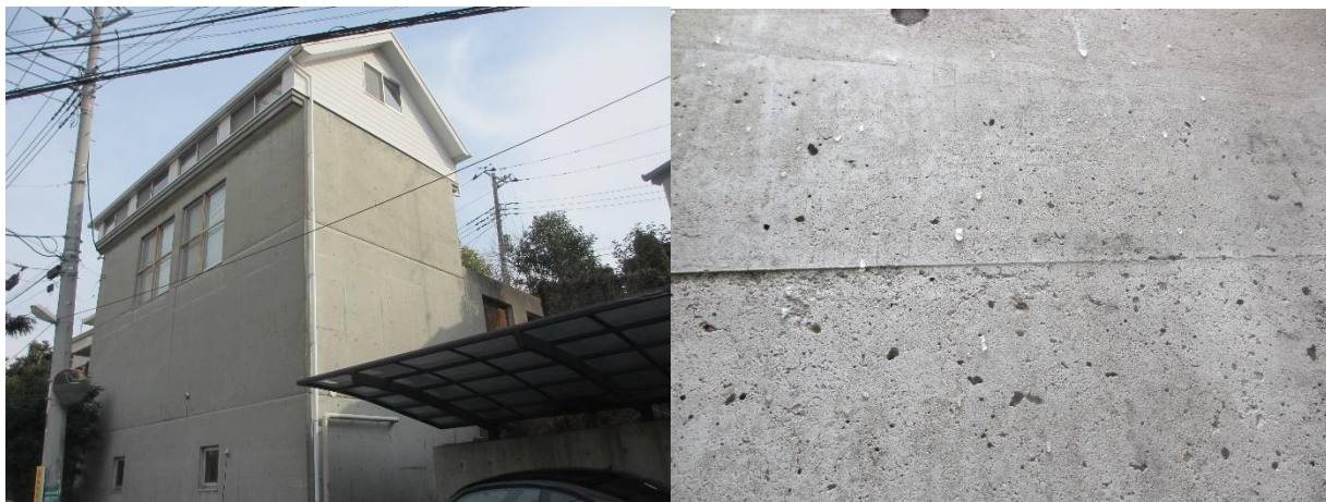
■ 工事名:H様邸外壁ほか改修工事 ■ 施工年:2018年 ■ 施工場所:千葉県 ■ 施工数量:320㎡ ■ 目的:外壁ほか劣化対策・防汚
