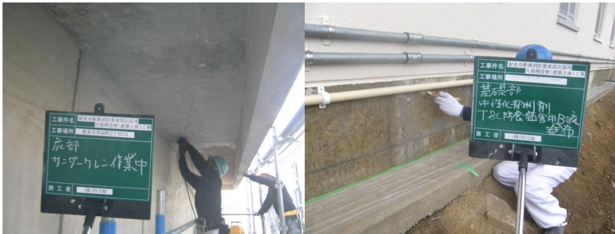
■ 工事名:射水市新湊消防署東部出張所大規模改修(建築主体)工事 ■ 施工年:2018年 ■ 施工場所:富山県 ■ 施工数量:132㎡ ■ 目的:塩害対策
