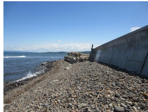
■ 工事名:平沢漁港海岸高潮対策工事 ■ 施工年:2019年 ■ 施工場所:秋田県 ■ 施工数量:35㎡ ■ 目的:波返LPCa部材に対する含浸材の性能評価(摩耗、塩害、凍害等)
