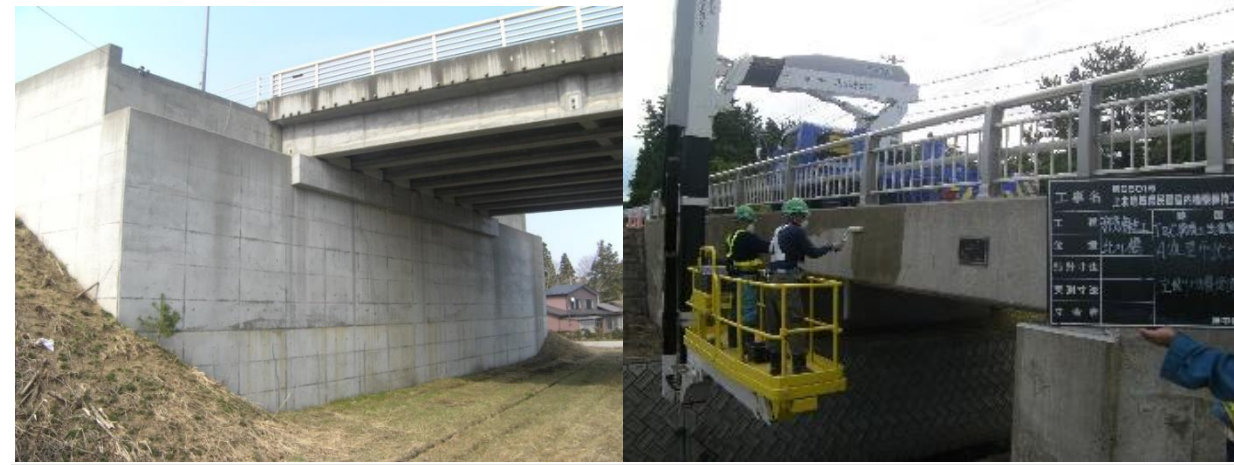
■ 工事名:上北地域県民局管内橋梁維持工事国道338号線南川橋・北川橋 ■ 施工年:2014年 ■ 施工場所:青森県 ■ 施工数量:500㎡ ■ 目的:橋梁(橋台・桁・地覆・床板下面)塩害対策
