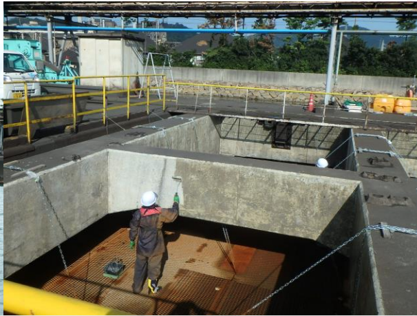
■ 工事名:新日本電工(株)徳島工場(3万トン棧橋補修工事) ■ 施工年:2016年 ■ 施工場所:徳島県 ■ 施工数量:2000㎡ ■ 目的:既設塗膜除去後含浸材塗布・塩害対策
