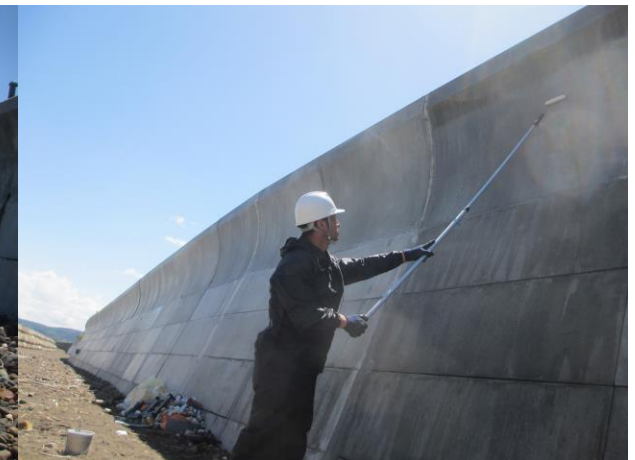
■ 工事名:平沢漁港海岸高潮対策工事 ■ 施工年:2019年 ■ 施工場所:秋田県 ■ 施工数量:35㎡ ■ 目的:波返LPCa部材に対する含浸材の性能評価(摩耗、塩害、凍害等)
