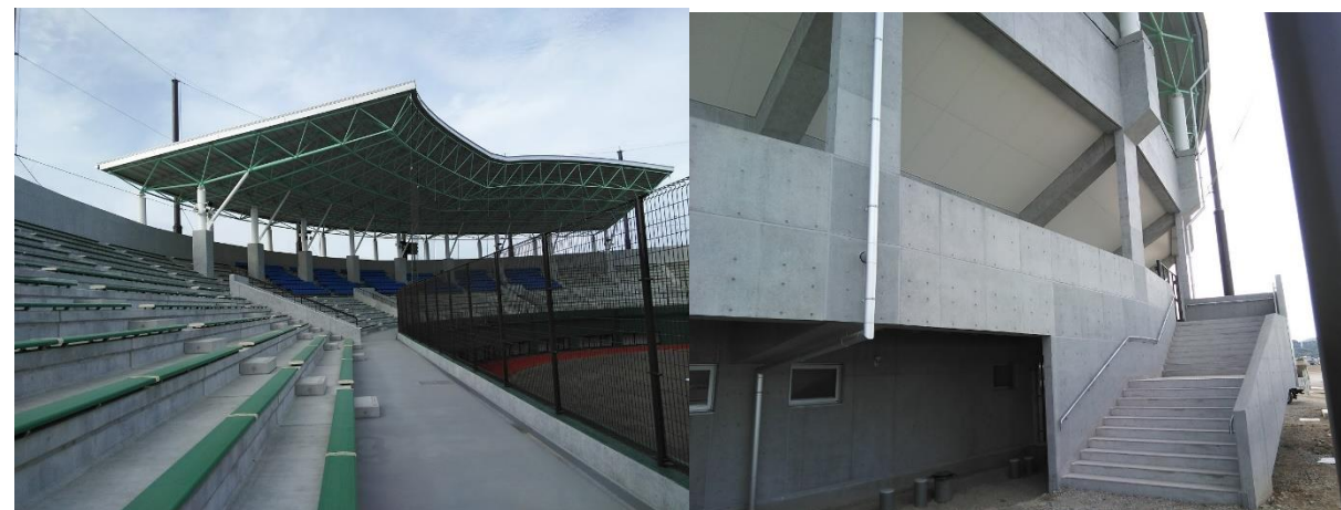
■ 工事名:諫早市新野球場建築主体工事 ■ 施工年:2017年 ■ 施工場所:長崎県 ■ 施工数量:5369㎡ ■ 目的:コンクリート部材(スタンド、外壁、梁、柱、上裏)塩害対策
