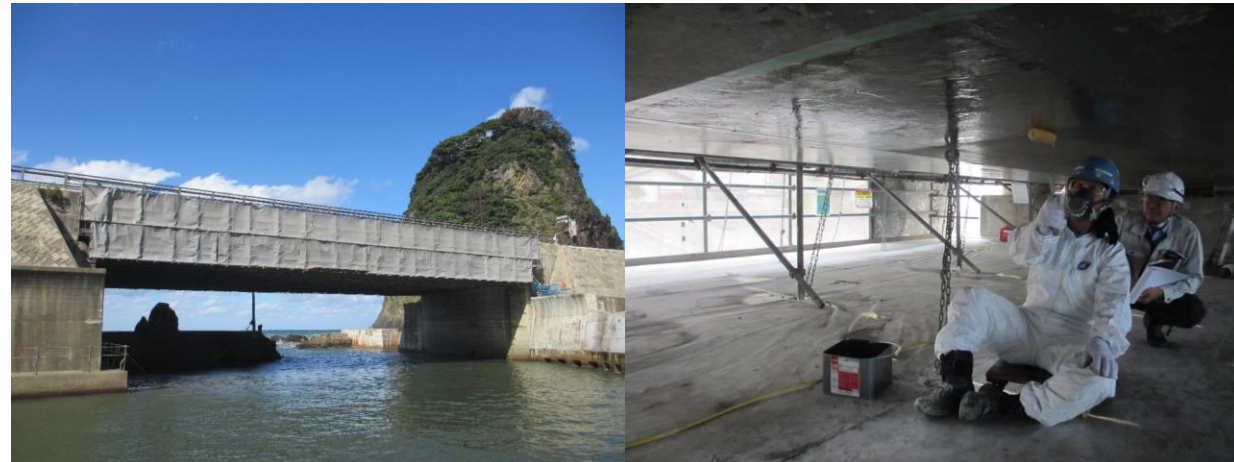
■ 工事名:H25暮坪橋補修工事 ■ 施工年:2013年 ■ 施工場所:山形県 ■ 施工数量:56㎡ ■ 目的:床版下面塩害対策
