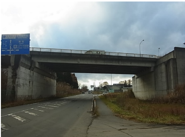
■ 工事名:十和田管内橋梁維持工事 ■ 施工年:2014年 ■ 施工場所:青森県 ■ 施工数量:532㎡ ■ 目的:ひび割れ(0.2mm未満)対策、凍害対策
