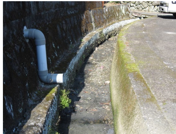
■ 工事名:平成21年度丸目地区排水路改良工事 ■ 施工年:2010年 ■ 施工場所:宮崎県 ■ 施工数量:180㎡ ■ 目的:水路補修、下地3軸メッシュシート補強工、モルタル仕上げ
