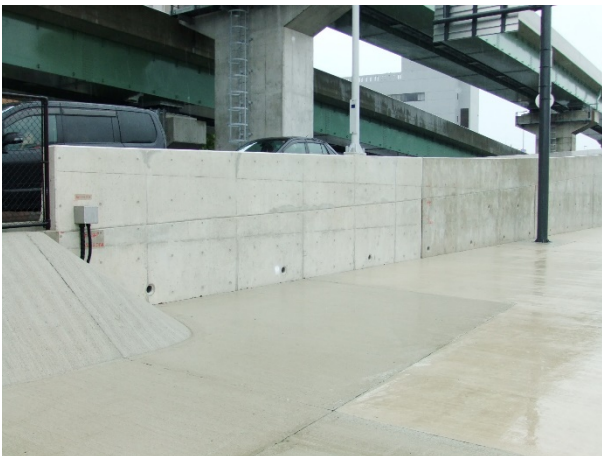
■ 工事名:浦上川線(P6~P7)高架橋床版防食工事 ■ 施工年:2010年 ■ 施工場所:長崎県 ■ 施工数量:840㎡ ■ 目的:コンクリート床版塩害対策、壁高欄(試験施工)
