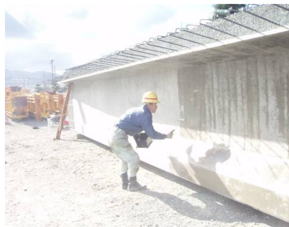
■ 工事名:平成18年度153号線上穂沢川橋PC上部工事 ■ 施工年:2007年 ■ 施工場所:長野県 ■ 施工数量:1000㎡ ■ 目的:上部工塩害対策
