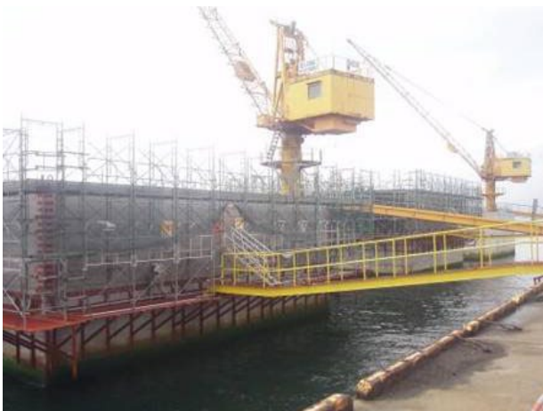
■ 工事名:平成20年度小名浜港東地区護岸(防波)本体工事 ■ 施工年:2008年 ■ 施工場所:福島県 ■ 施工数量:不明 ■ 目的:ケーソン打ち継ぎ部塩害対策
