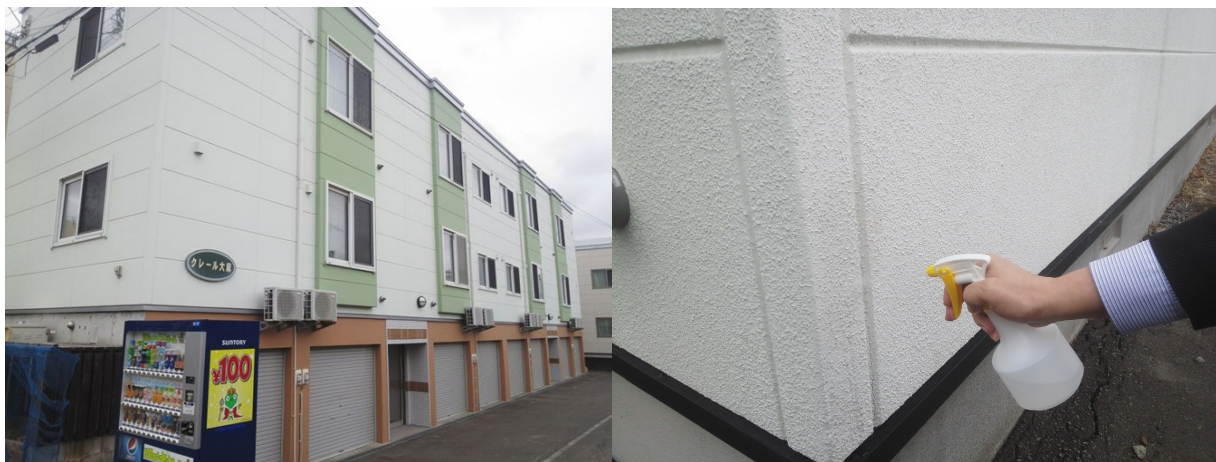
■ 工事名:クレール大麻 外壁改修工事 ■ 施工年:2016年 ■ 施工場所:北海道 ■ 施工数量:260㎡ ■ 目的:外壁(築9年)旭化成ヘーベル塗装下地撥水性付与・防汚
