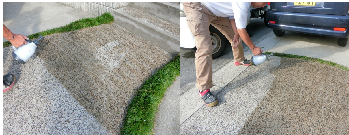
■ 工事名:個人住宅新築工事 ■ 施工年:2016年 ■ 施工場所:福岡県 ■ 施工数量:50㎡ ■ 目的:個人住宅外構廻り、コンクリート洗い出し仕上げ改質・防汚
