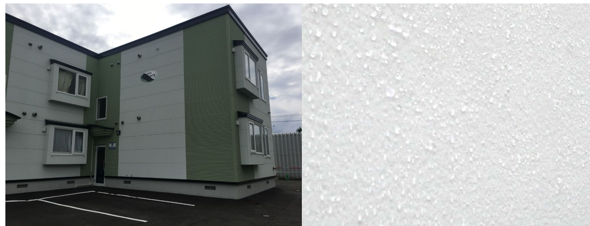
■ 工事名:東苗穂レモンハイツ 外壁改修工事 ■ 施工年:2016年 ■ 施工場所:北海道 ■ 施工数量:390㎡ ■ 目的:外壁(築12年)旭化成ヘーベル塗装下地撥水性付与・防汚
