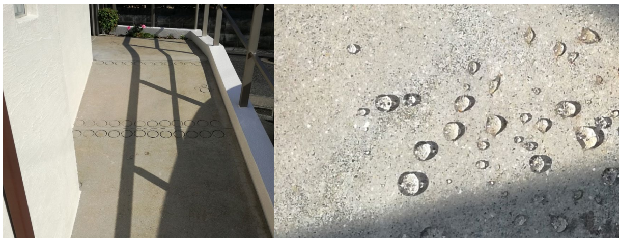
■ 工事名:個人住宅外構改修工事 ■ 施工年:2016年 ■ 施工場所:福岡県 ■ 施工数量:10㎡ ■ 目的:個人住宅外構廻り・スロープ モルタル仕上げ改質・防汚
