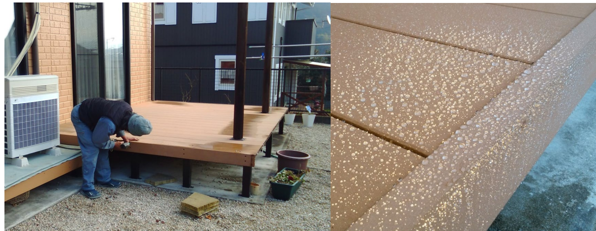
■ 工事名:個人住宅外構改修工事 ■ 施工年:2016年 ■ 施工場所:福岡県 ■ 施工数量:10㎡ ■ 目的:個人住宅人工木ウッドデッキ撥水・防汚
