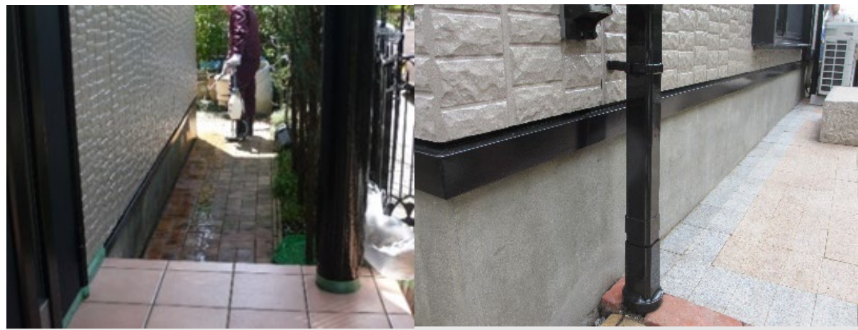
■ 工事名:0様邸基礎改修他工事 ■ 施工年:2016年 ■ 施工場所:神奈川県 ■ 施工数量:16㎡ ■ 目的:コンクリート基礎、犬走りインターロッキングブロック防汚・改質
