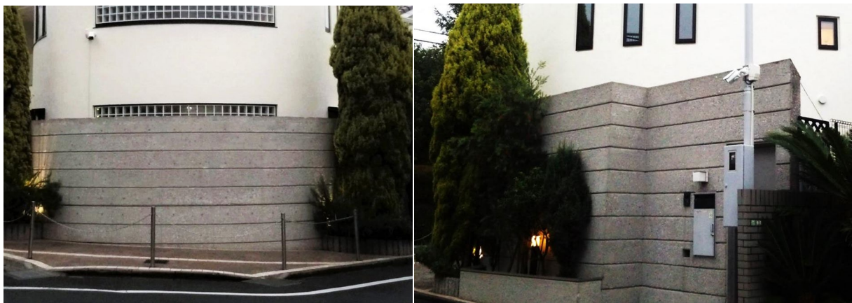
■ 工事名:個人住宅外構改修工事 ■ 施工年:2016年 ■ 施工場所:東京都 ■ 施工数量:115㎡ ■ 目的:個人住宅外構廻り、コンクリート小叩き仕上げ撥水・防汚
