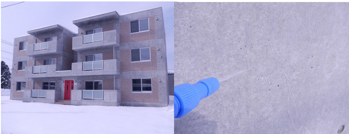
■ 工事名:集合住宅外壁コンクリート打ち放し面塗装工事 ■ 施工年:2019年 ■ 施工場所:北海道 ■ 施工数量:250㎡ ■ 目的:外壁コンクリート打ち放し面防汚
