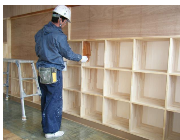
■ 工事名: 県立日立第一高等学校床改修工事 木製ロッカ-塗装 ■ 施工年: 2012年 ■ 施工場所: 岐阜県 ■ 施工数量: 146㎡ ■ 目的: 木材表面保護、着色
