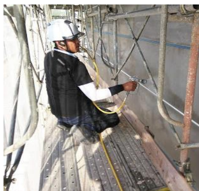
ナノコートプライマー塗布状況
