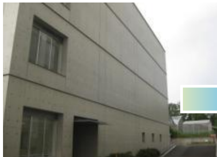
施工後(教育施設外壁・愛知)
