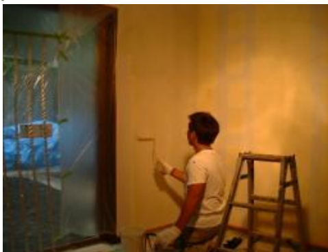
施工中(宿泊施設・神奈川)
