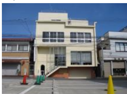
施工後(住宅外壁・青森)
