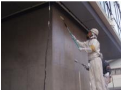
施工中(研究施設外部・東京)
