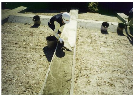
〈欠落部補修状況〉
