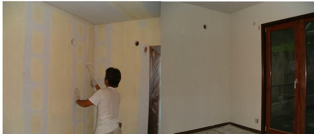
■ 工事名:個人住宅内装塗装工事(横浜) ■ 施工年:2006年 ■ 施工場所:神奈川県 ■ 施工数量:50㎡ ■ 目的:内装壁紙着色・調湿・VOC対策
