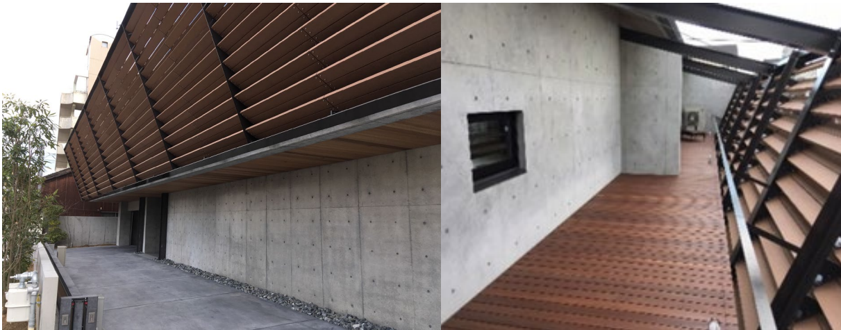
■ 工事名:K様ビル新築工事 ■ 施工年:2018年 ■ 施工場所:大阪府 ■ 施工数量:1,760㎡ ■ 目的:コンクリート内外壁撥水性付与、劣化因子浸透抑制ほか
