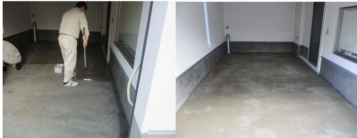
■ 工事名:A様邸新築工事 ■ 施工年:2015年 ■ 施工場所:東京都 ■ 施工数量:37㎡ ■ 目的:駐車場土間コンクリート及び基礎コンクリート外周(新設)
