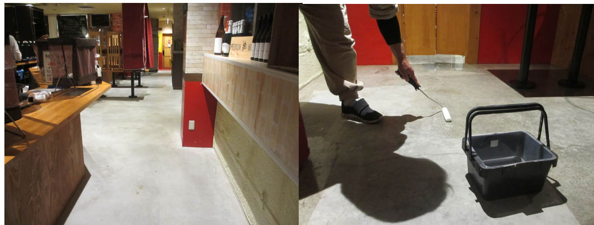
■ 工事名:店舗床表面含浸材塗布工事 ■ 施工年:2017年 ■ 施工場所:愛知県 ■ 施工数量:50㎡ ■ 目的:コンクリート床耐油性付与
