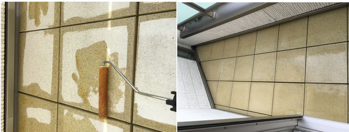
■ 工事名:B様邸新築工事 ■ 施工年:2018年 ■ 施工場所:東京都 ■ 施工数量:10㎡ ■ 目的:バルコニータイル防汚・吸水抑止
