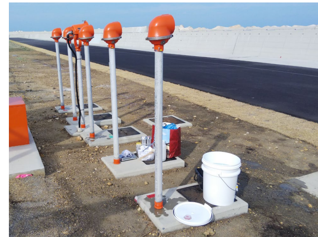
■ 工事名:那覇空港第2滑走路照明設備関連 液体ガラス塗布 ■ 施工年:2019年 ■ 施工場所:沖縄県 ■ 施工数量:パイプのみ ■ 目的:塩害防止及び紫外線劣化防止(灯器嵩上パイプ)
