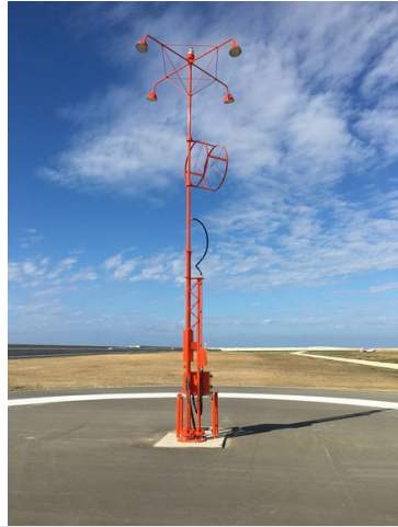
■ 工事名:那覇空港第2滑走路照明設備関連 液体ガラス塗布 ■ 施工年:2019年 ■ 施工場所:沖縄県 ■ 施工数量:架台足4本ほか ■ 目的:塩害防止及び紫外線劣化防止(橋梁上灯器および風向灯架台パイプ)
