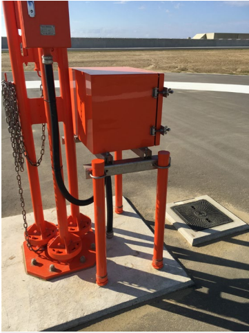
■ 工事名:那覇空港第2滑走路照明設備関連 液体ガラス塗布 ■ 施工年:2019年 ■ 施工場所:沖縄県 ■ 施工数量:架台足4本ほか ■ 目的:塩害防止及び紫外線劣化防止(橋梁上灯器および風向灯架台パイプ)
