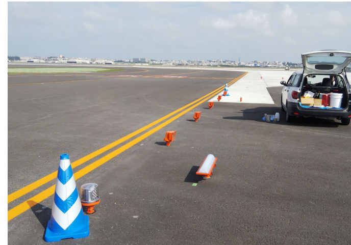
■ 工事名:那覇空港第2滑走路照明設備関連 液体ガラス塗布 ■ 施工年:2019年 ■ 施工場所:沖縄県 ■ 施工数量:6機 ■ 目的:塩害防止及び紫外線劣化防止(滑走路末端灯灯器)
