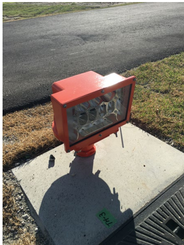
■ 工事名:那覇空港第2滑走路照明設備関連 液体ガラス塗布 ■ 施工年:2019年 ■ 施工場所:沖縄県 ■ 施工数量:6機 ■ 目的:塩害防止及び紫外線劣化防止(滑走路末端灯灯器)
