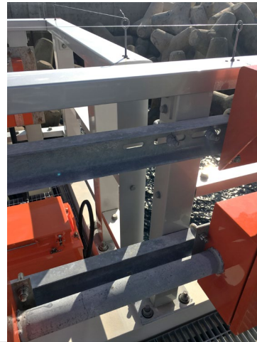
■ 工事名:那覇空港第2滑走路照明設備関連 液体ガラス塗布 ■ 施工年:2019年 ■ 施工場所:沖縄県 ■ 施工数量:架台足4本ほか ■ 目的:塩害防止及び紫外線劣化防止(橋梁上灯器および風向灯架台パイプ)
