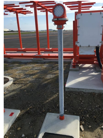
■ 工事名:那覇空港第2滑走路照明設備関連 液体ガラス塗布 ■ 施工年:2019年 ■ 施工場所:沖縄県 ■ 施工数量:パイプのみ ■ 目的:塩害防止及び紫外線劣化防止(灯器嵩上パイプ)
