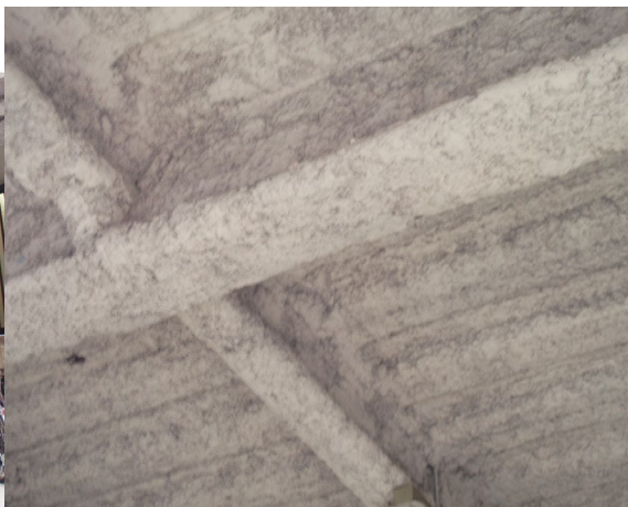
■ 工事名:医療機関駐車場石綿封じ込め工事 ■ 施工年:2007年 ■ 施工場所:東京都 ■ 施工数量:80㎡ ■ 目的:吹付け石綿封じ込め
