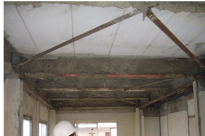
■ 工事名:アパート解体工事 ■ 施工年:2007年 ■ 施工場所:東京都 ■ 施工数量:500㎡ ■ 目的:天井吹き付け材固化
