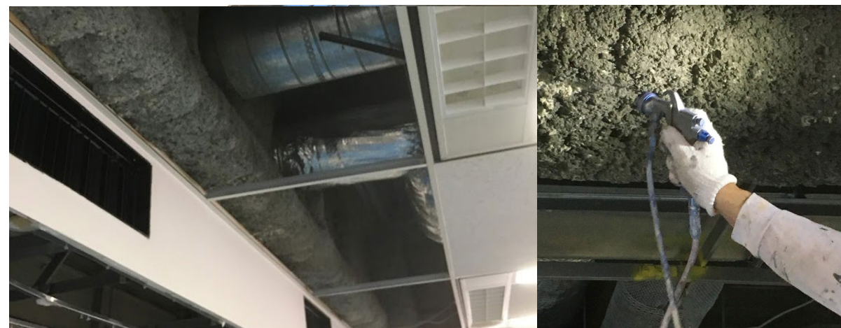
■ 工事名: タワービルオフィス棟天井被覆材固化工事 ■ 施工年: 2018年 ■ 施工場所: 東京都 ■ 施工数量: 400㎡ ■ 目的: 貸し事務所スケルトン化に伴うロックウール固化
