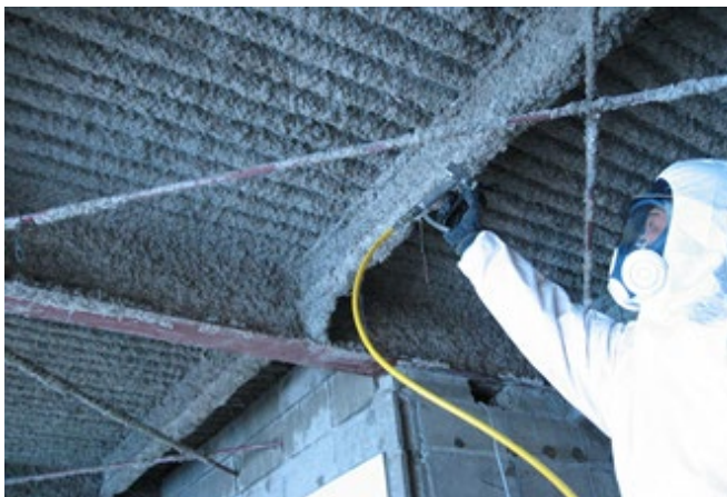
■ 工事名:民間企業施設石綿除去工事 ■ 施工年:2007年 ■ 施工場所:岐阜県 ■ 施工数量:546㎡ ■ 目的:吹付け石綿除去
