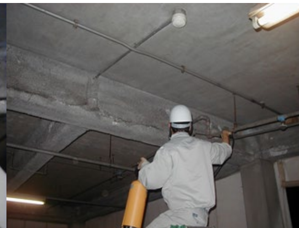
■ 工事名:東急パーキング烏対策工事 ■ 施工年:2005年 ■ 施工場所:東京都 ■ 施工数量:40㎡ ■ 目的:天井吹き付け材固化
