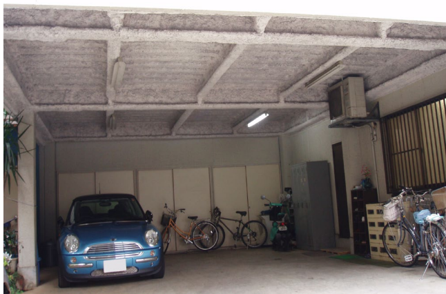
■ 工事名:医療機関駐車場石綿封じ込め工事 ■ 施工年:2007年 ■ 施工場所:東京都 ■ 施工数量:80㎡ ■ 目的:吹付け石綿封じ込め
