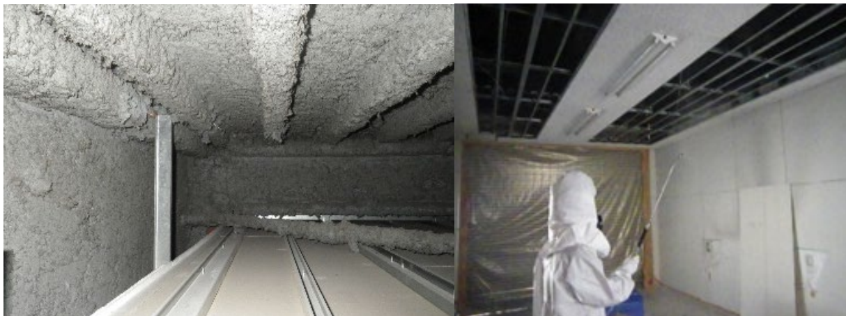
■ 工事名: 兎びや第二ビルアスベスト封込工事 ■ 施工年: 2016年 ■ 施工場所: 兵庫県 ■ 施工数量: 300㎡(t=10mm) ■ 目的: 天井材・梁吹付けアスベスト封じ込め
