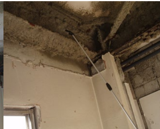
■ 工事名:アパート解体工事 ■ 施工年:2007年 ■ 施工場所:東京都 ■ 施工数量:500㎡ ■ 目的:天井吹き付け材固化
