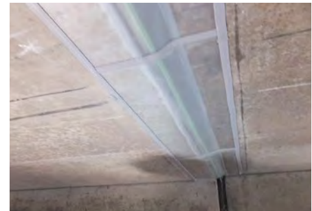
段差のある目地に施工した例
