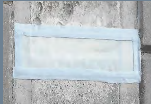
パッチシールクロス貼付後、パッチテープで端部を処理した例。
