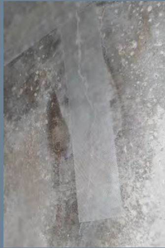
パッチシールクロス貼付後、パッチテープで端部を処理した例。
